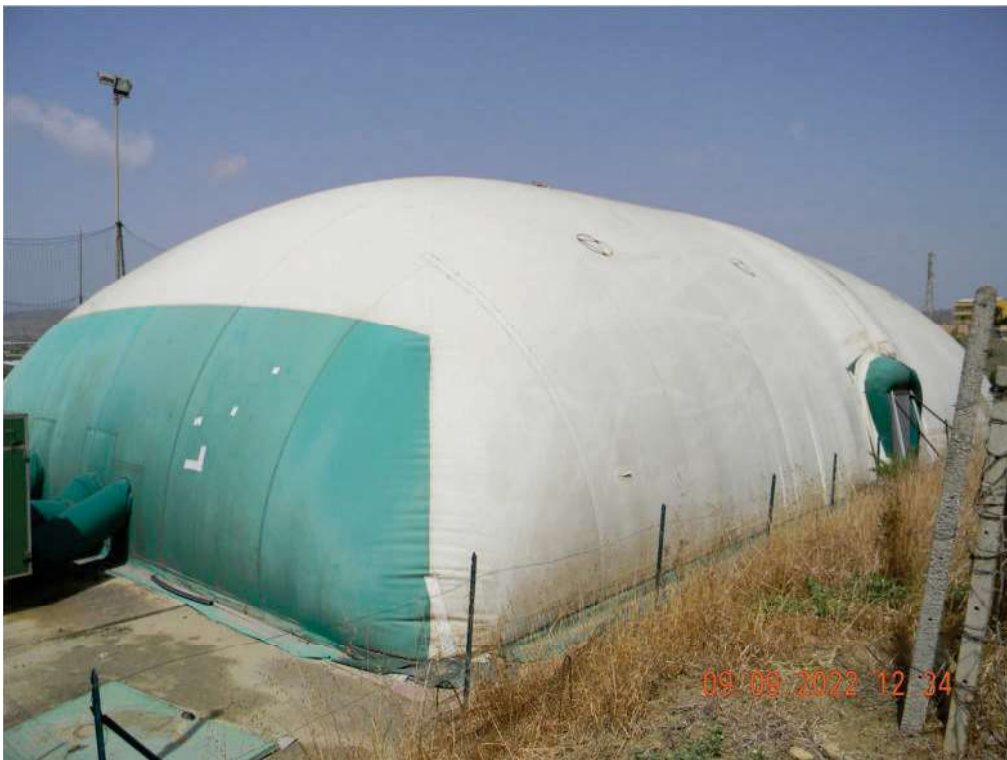
FOTO 12 - Struttura pressostatica (vista da sud-est).
