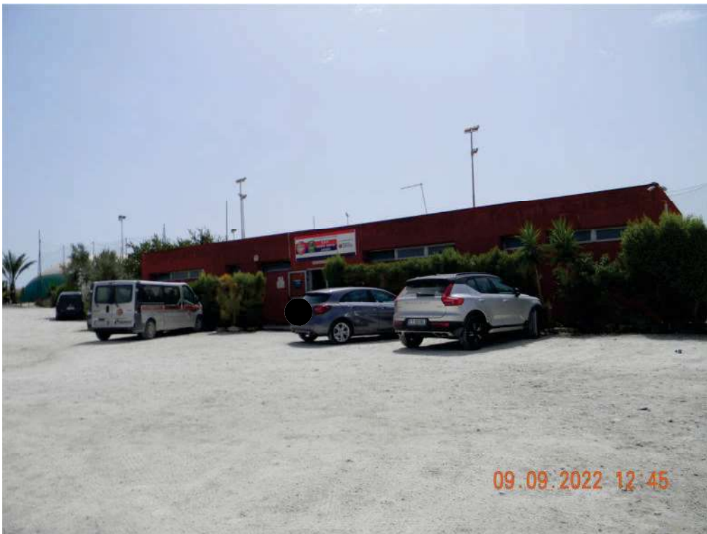
FOTO 02 - Vista dell'edificio da nord-ovest.
