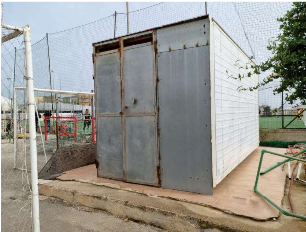
FOTO 32 - Container adibito a deposito attrezzi.
