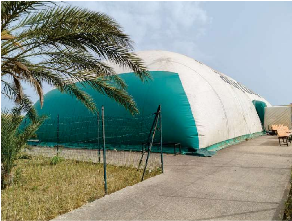
FOTO 11 - Struttura pressostatica (vista da nord-ovest).
