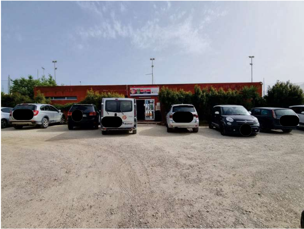
FOTO 03 - Area parcheggio e prospetto nord dell'edificio.
