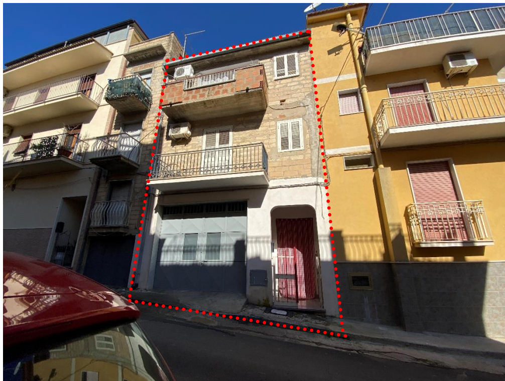
Foto n.2 Prospetto su via Pasubio
