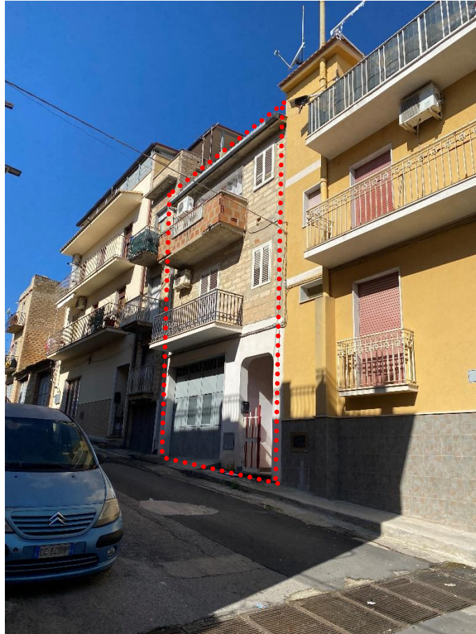
Foto n.1 Prospetto su via Pasubio
