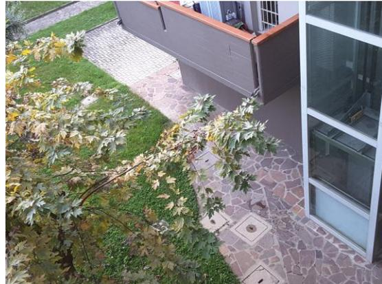
Il complesso condominiale è dotato di tre piattaforme elevatrici (una per ogni corpo scala), poste all'esterno nell'area cortilizia e realizzate negli anni 2008-2010 che hanno una struttura autoportante in metallo e tamponamenti in cristallo.
