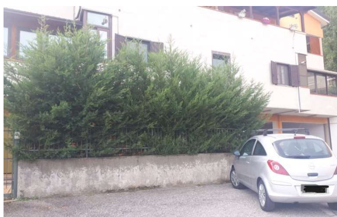
2 -Foto prospettiva esterna di una parte della corte dell'Unità immobiliare, posta al Piano Seminterrato Primo del fabbricato denominato convenzionalmente Scala "A".
