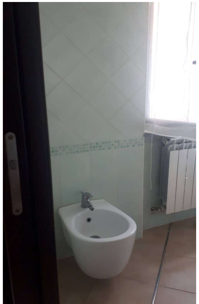
24 -Foto bagno del letto matrimoniale..
