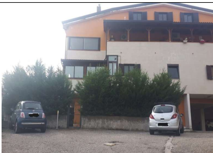
3 -Foto prospettiva dell'ingresso pedonale alla Corte dell'Unità immobiliare, posta al Piano Seminterrato Primo del fabbricato denominato convenzionalmente Scala "A".
