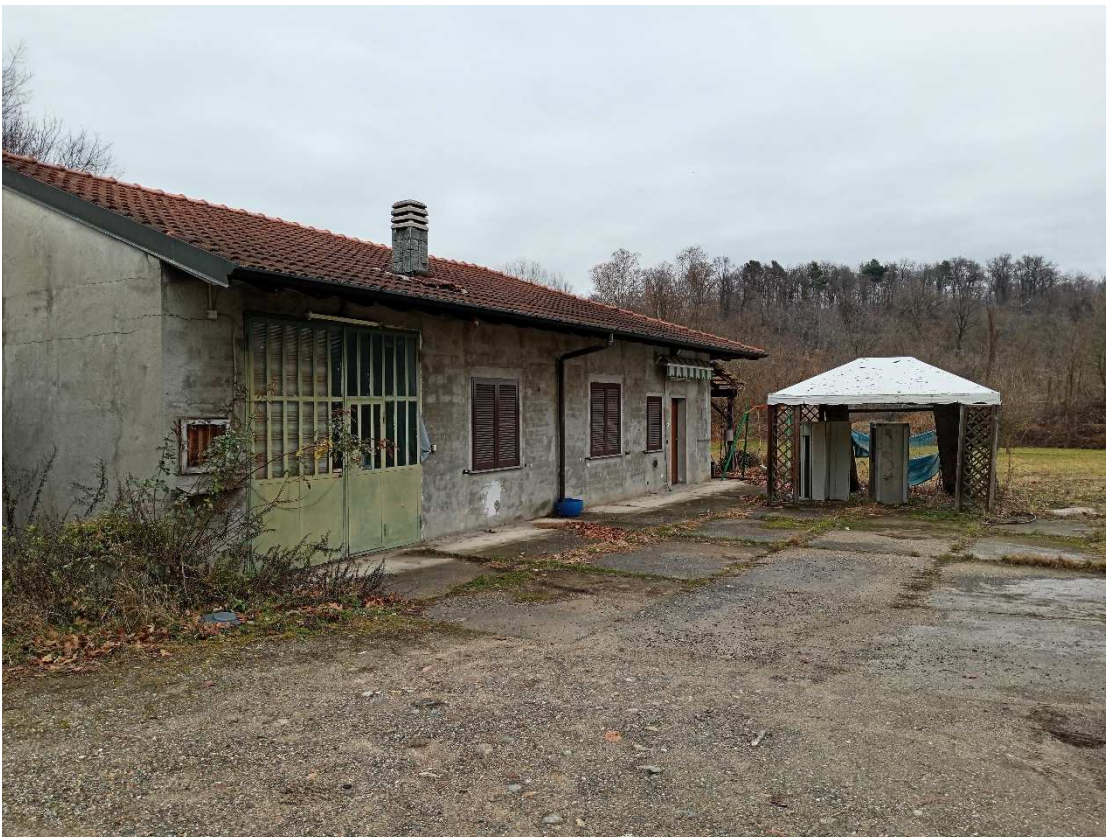
Foto 2 – abitazione foglio 1 particella 43 sub 501 (lotto 2)
