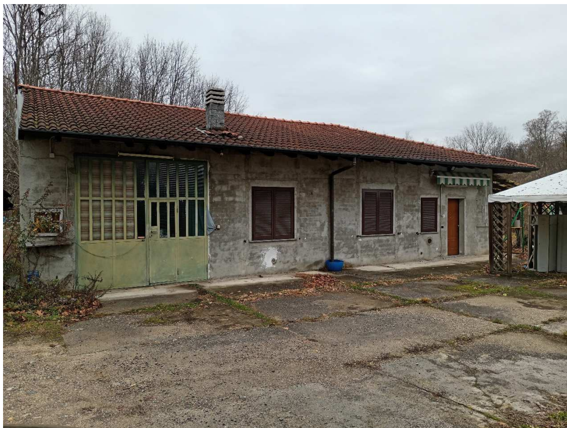
Foto 3 – abitazione foglio 1 particella 43 sub 501 (lotto 2)
