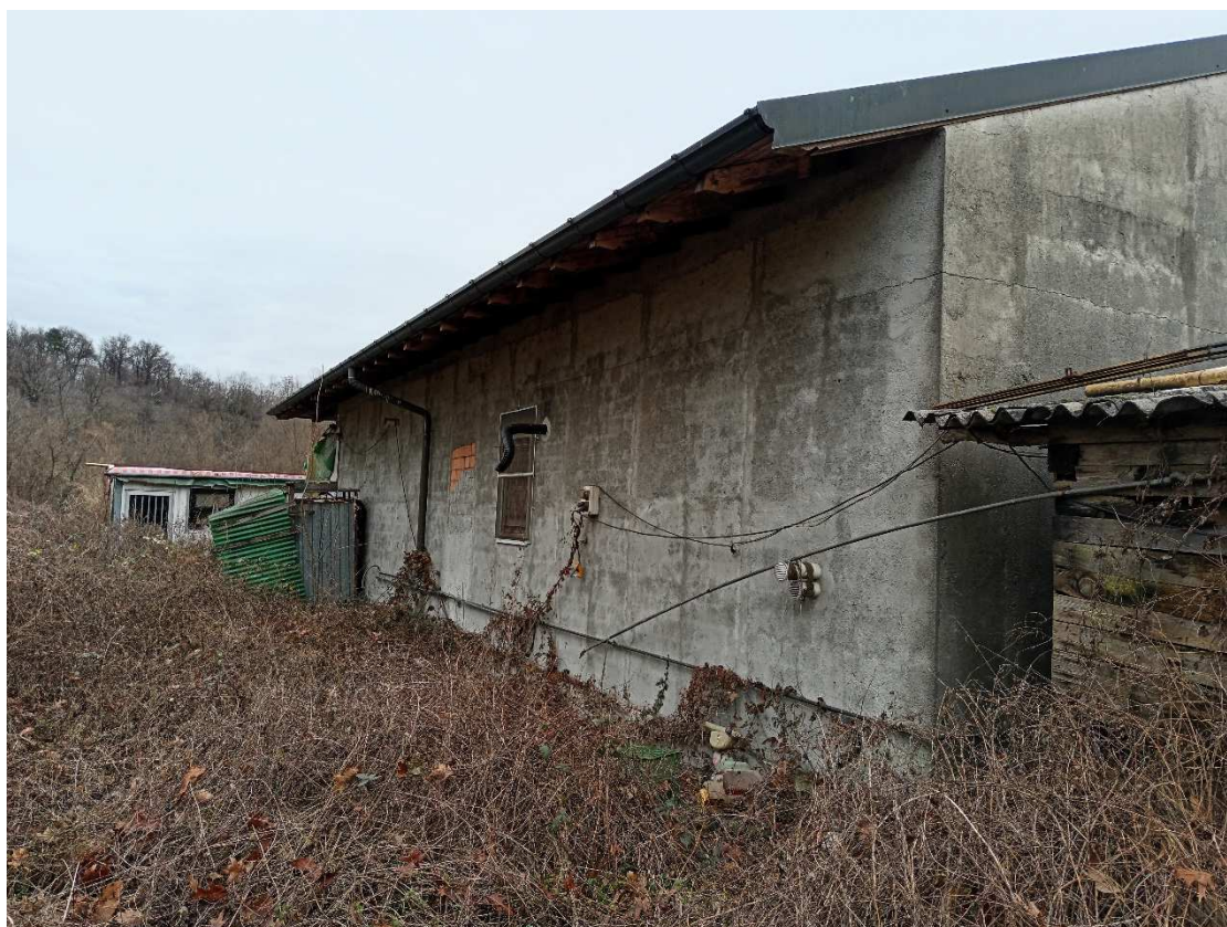
Foto 4 – altra vista abitazione foglio 1 particella 43 sub 501 (lotto 2)
