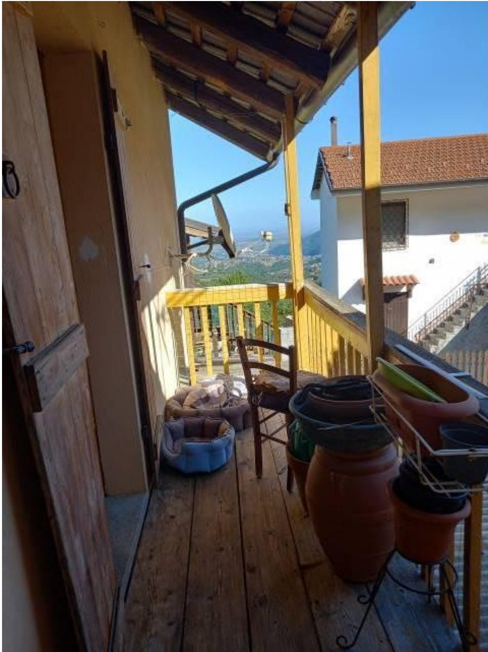
Fotografia n. 19 – Particolare del balcone
