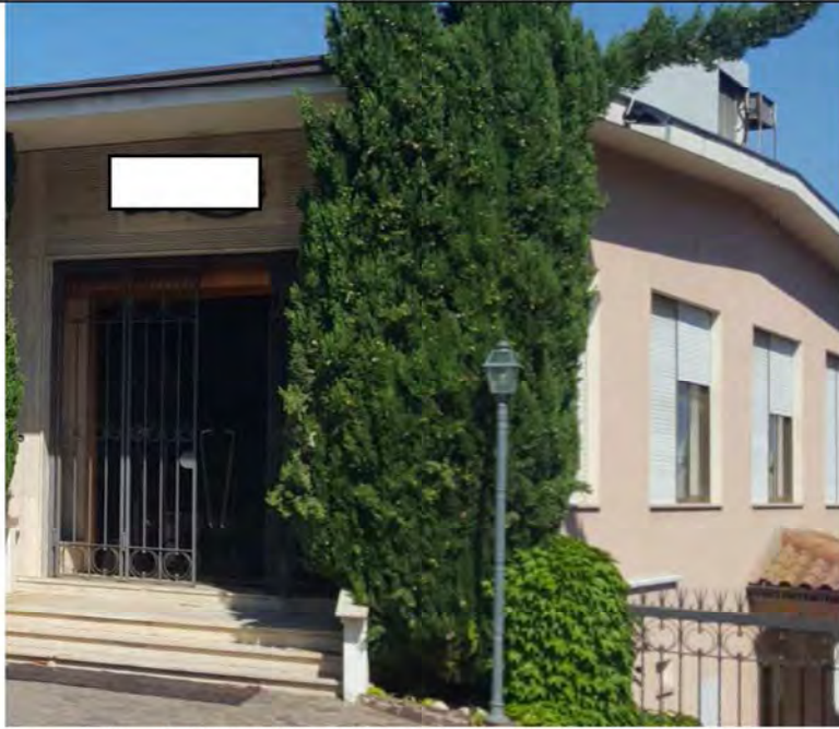
Fig. 8. Particolare infisso in ferro, ingresso principale.
