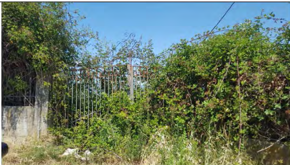
Fig. 48. Accesso alla corte prima della pulizia.
