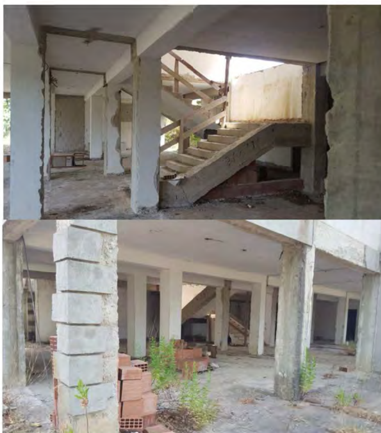
Fig. 41. Corpo A, stato interno.
