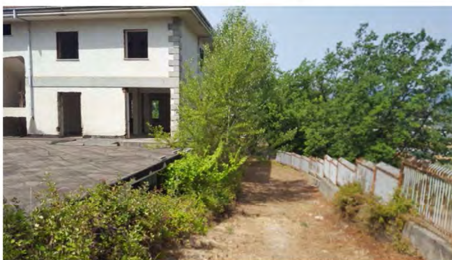
Fig. 50. Accesso alla corte dopo la pulizia.
