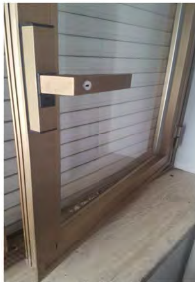
Fig. 9. Infissi esterno, in alluminio a vetro singolo.
