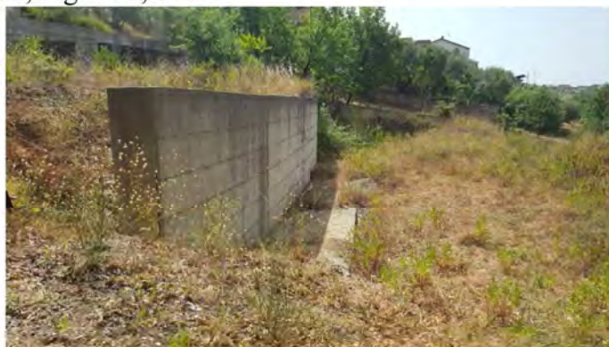
Fig. 44 a. Muri di contenimento.
