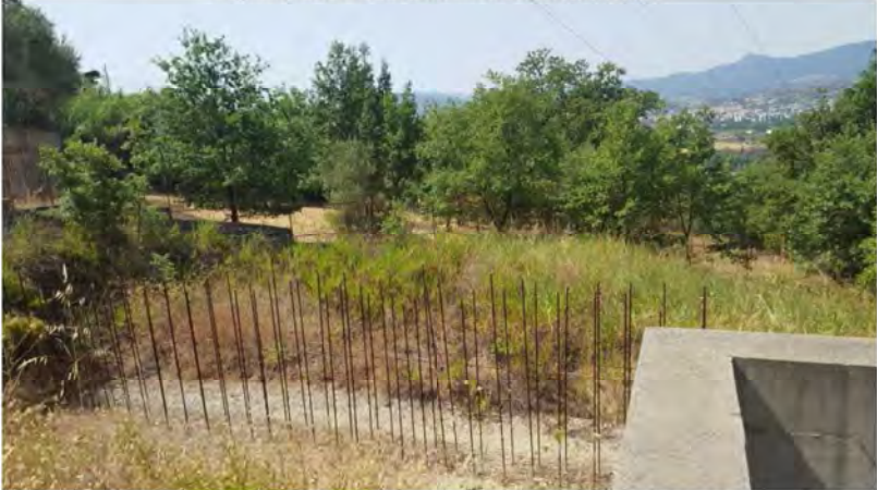
Fig. 45. Fondazione con i relativi ferri di armatura per il muro di sostegno.
