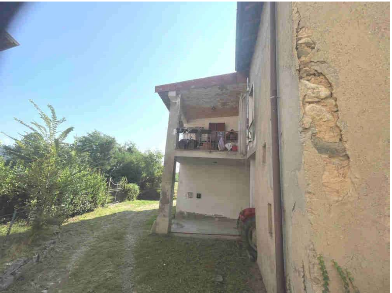
6. Portico al piano terreno e loggiato al piano superiore (di proprietà)
