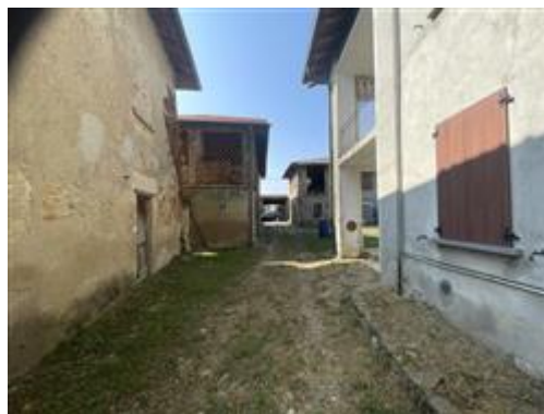
Cascina Campù Superiore porticato e loggia soprastante
