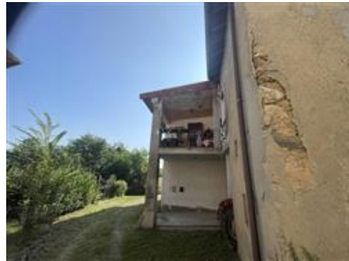
Cascina Campù Superiore, loggia al piano 1°
