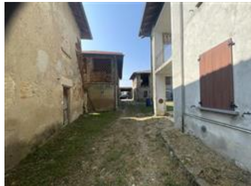
Cascina Campù Superiore porticato e loggia soprastante
