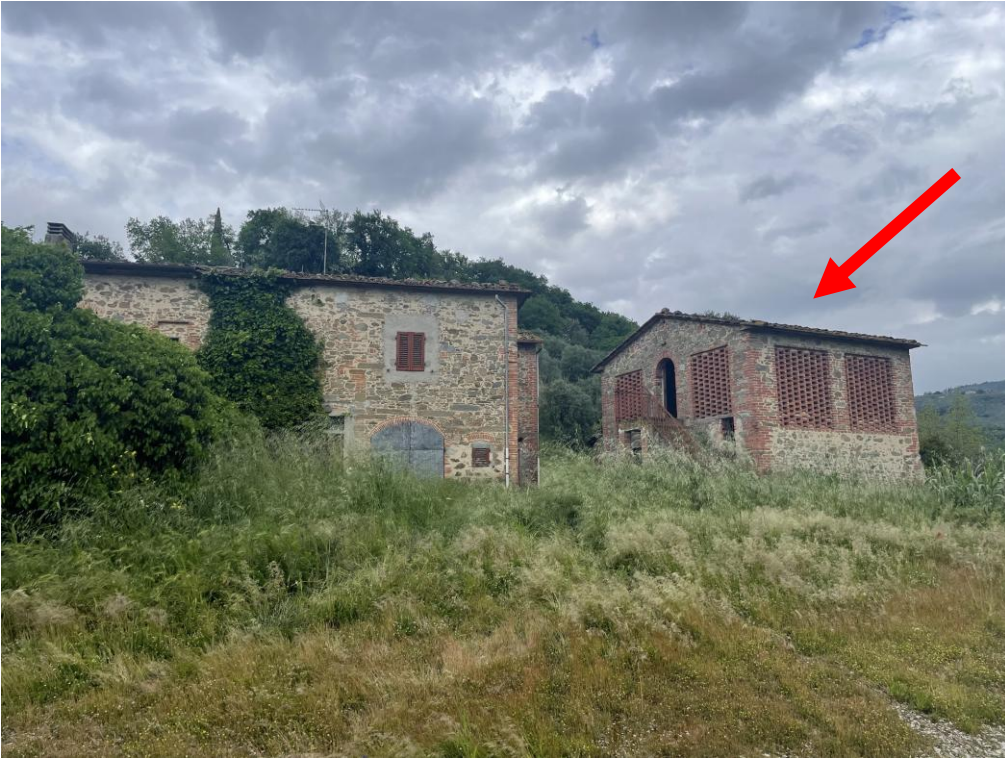
Facciata principale sulla strada d'accesso
