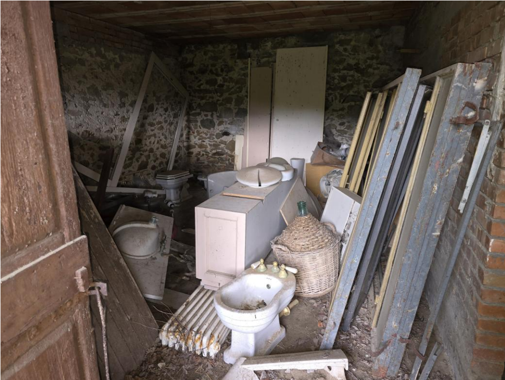
Locale deposito al piano terra
