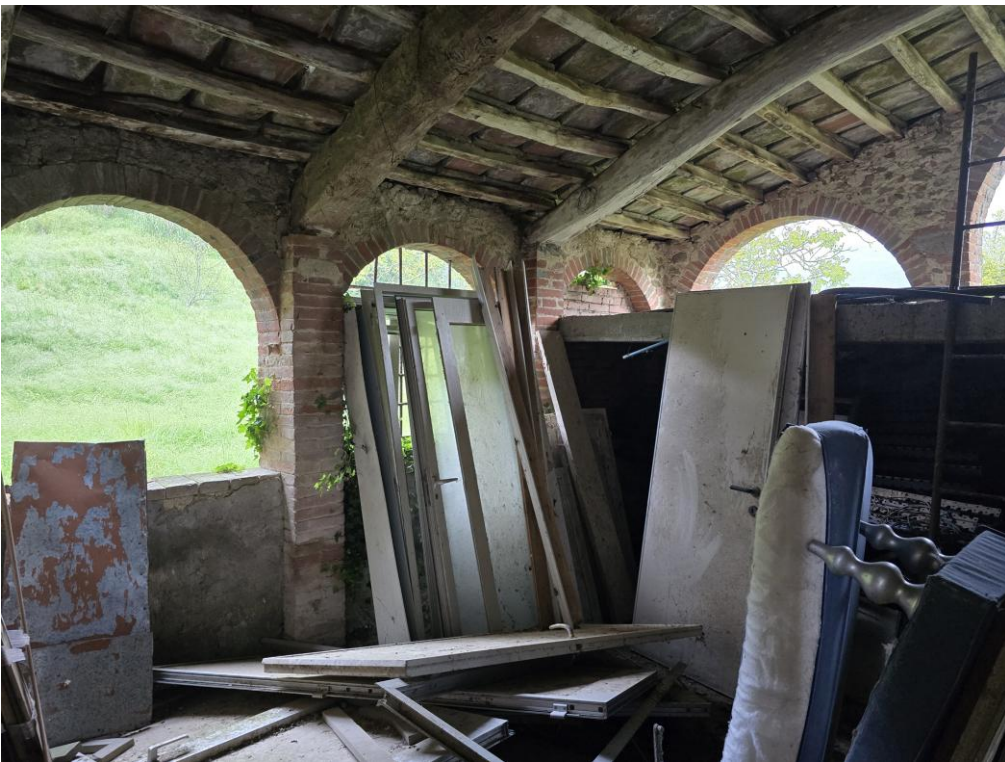
Locale deposito al piano terra - edificio attiguo
