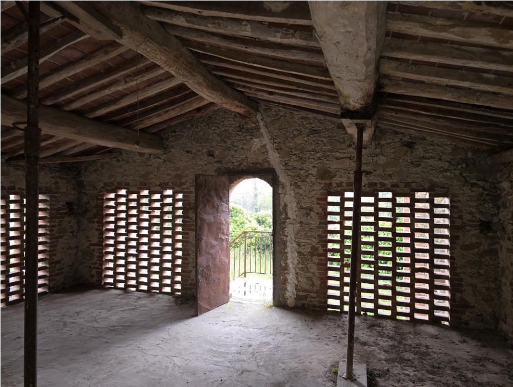
Locale ex fienile al piano primo
