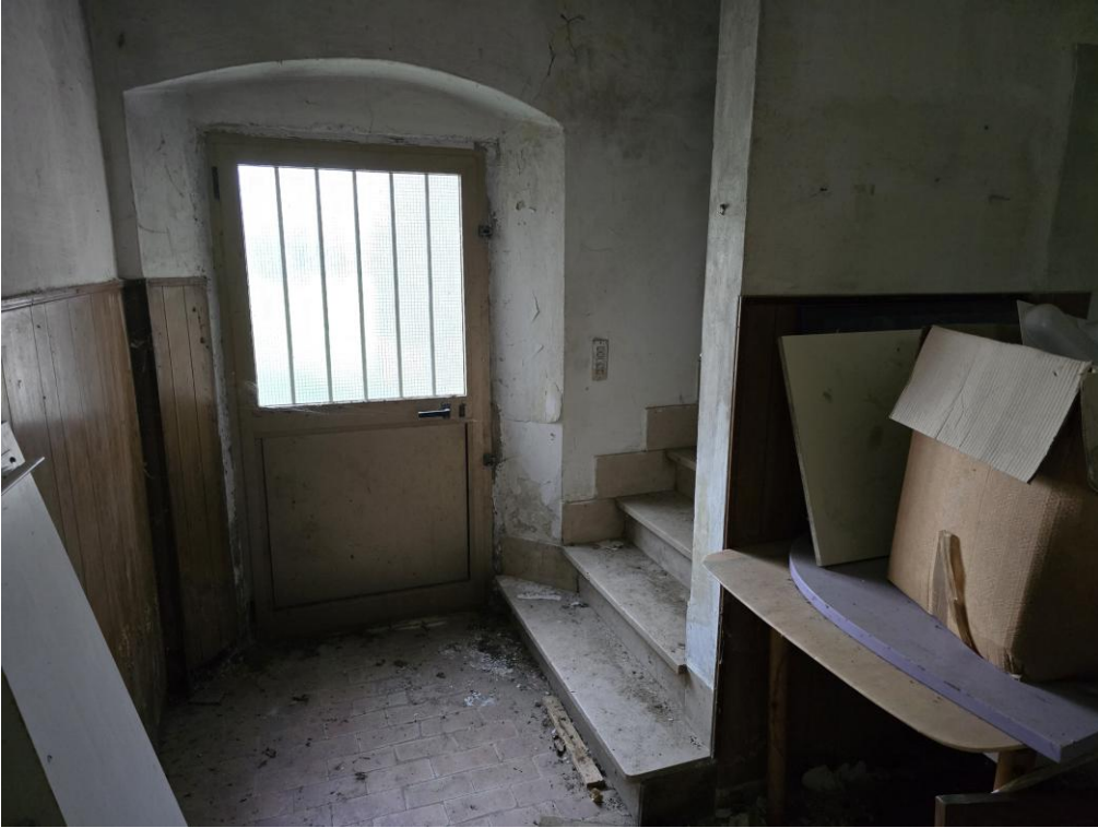
Rampa di accesso al piano primo
