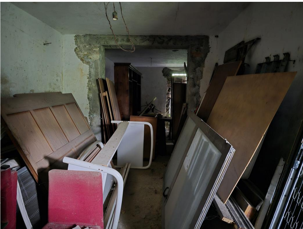
Locali identificati come "ex cantina" al piano terra
