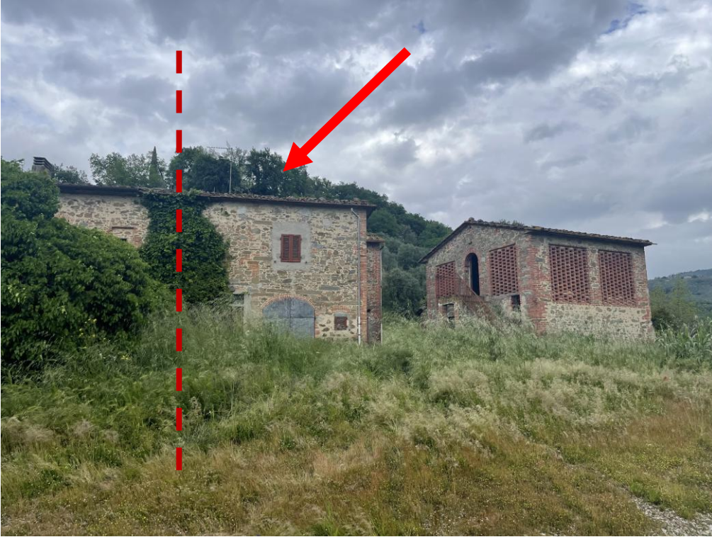
Facciata principale sulla strada d'accesso
