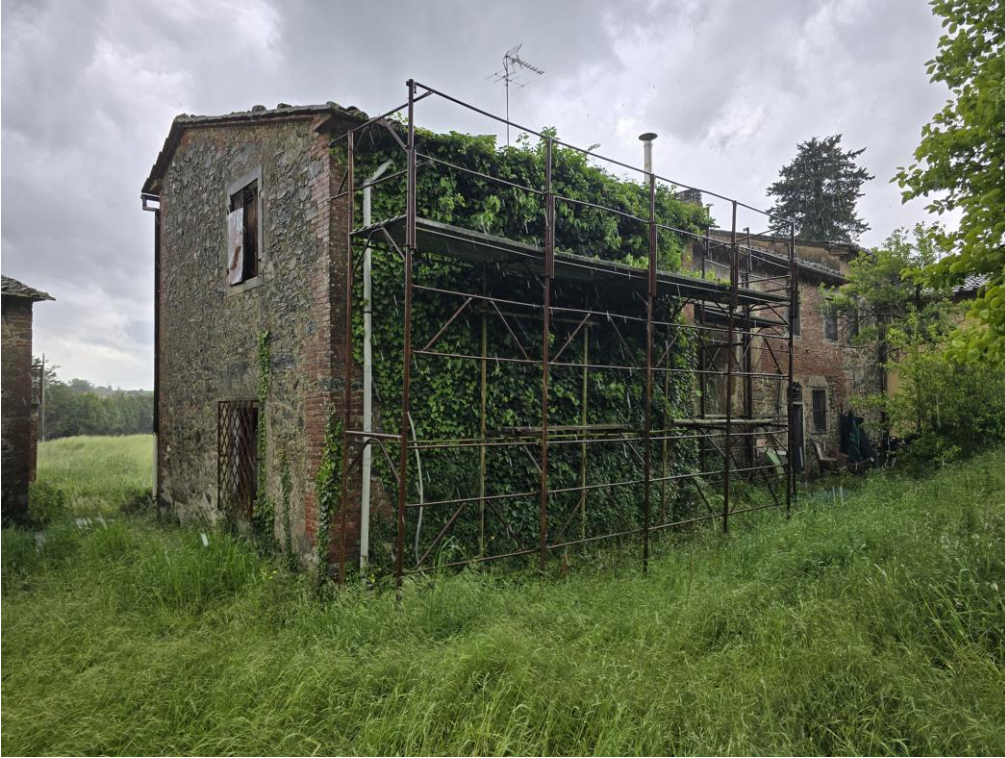
Facciata sul retro
