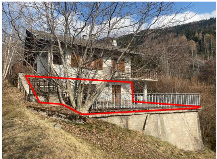
L'edificio presenta caratteristiche costruttive tradizionali della zona montana in cui sorge con prospetti intonacati "a sbriccio" e tinteggiati colore bianco, zoccolatura perimetrale anch'essa intonacato "a
