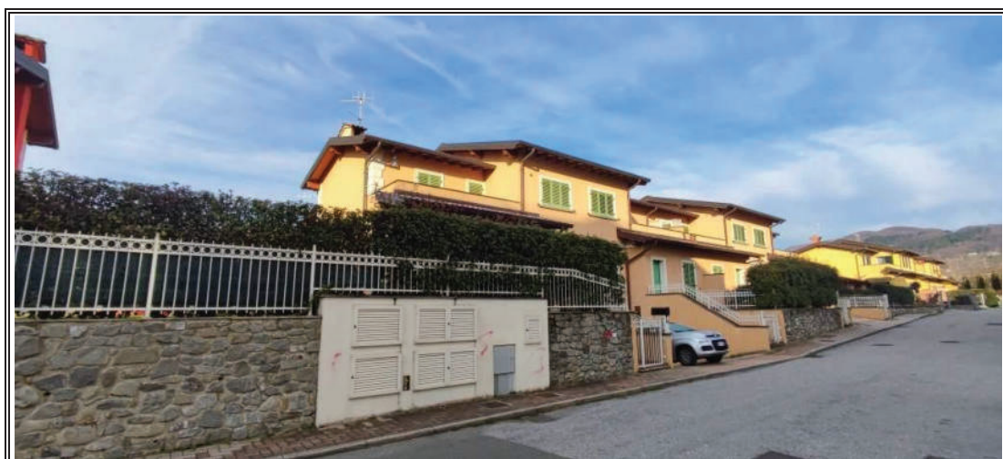
Foto n. 3 – Vista del fabbricato angolo SUD/EST
