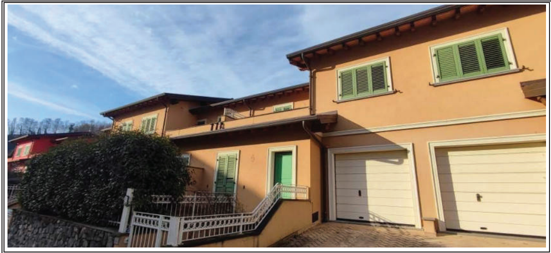
Foto n. 4 – Appartamento mapp. 1580 sub 2 – Facciata EST
