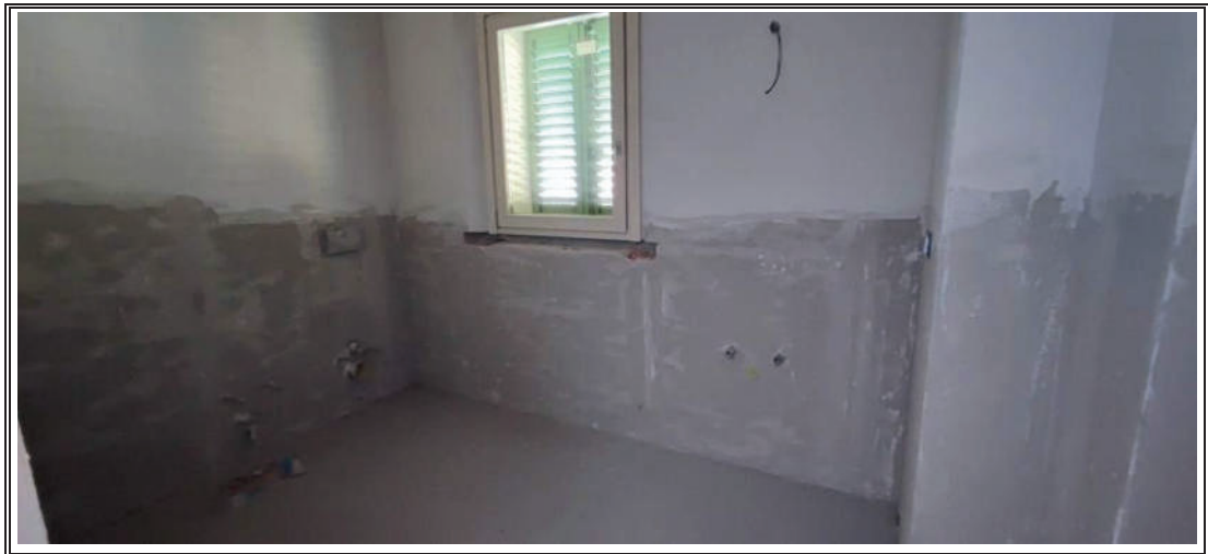
Foto n. 31 – Appartamento mapp. 1580 sub 3 – Bagno Piano Primo
