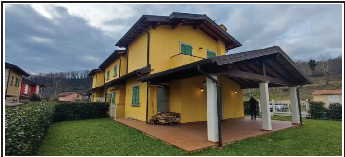
Foto n. 38 – Appartamento mapp. 1581 sub 12 – Angolo NORD OVEST
