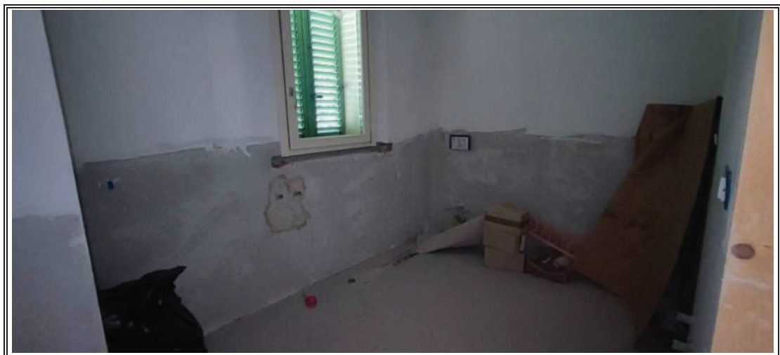
Foto n. 11 – Appartamento mapp. 1580 sub 2 – Bagno Piano terra
