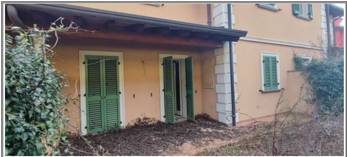
Foto n. 20 – Appartamento mapp. 1580 sub 3 – Facciata OVEST
