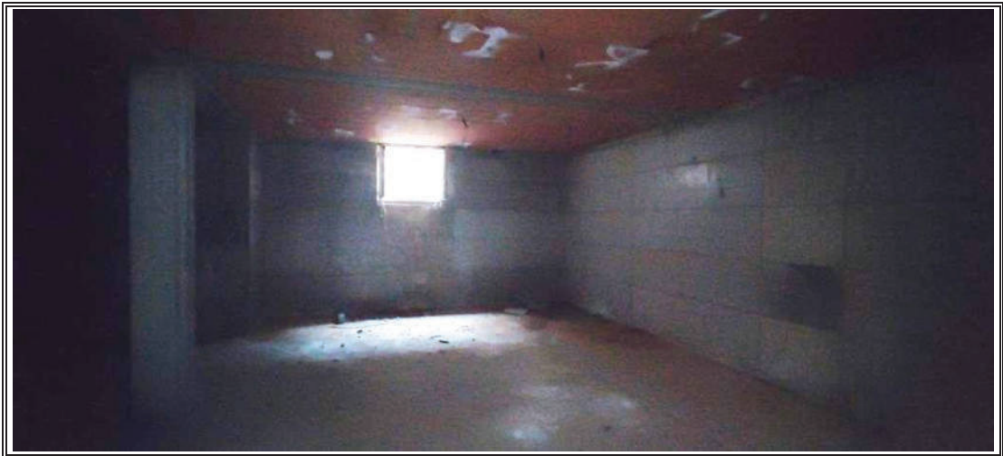
Foto n. 17 – Appartamento mapp. 1580 sub 2 – Cantina Piano interrato
