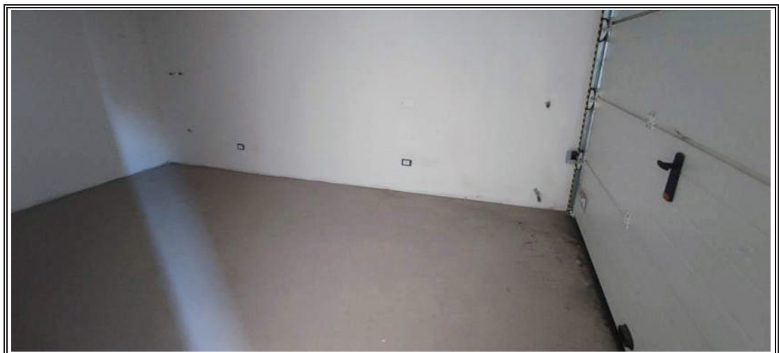
Foto n. 9 – Appartamento mapp. 1580 sub 2 – Garage Piano terra
