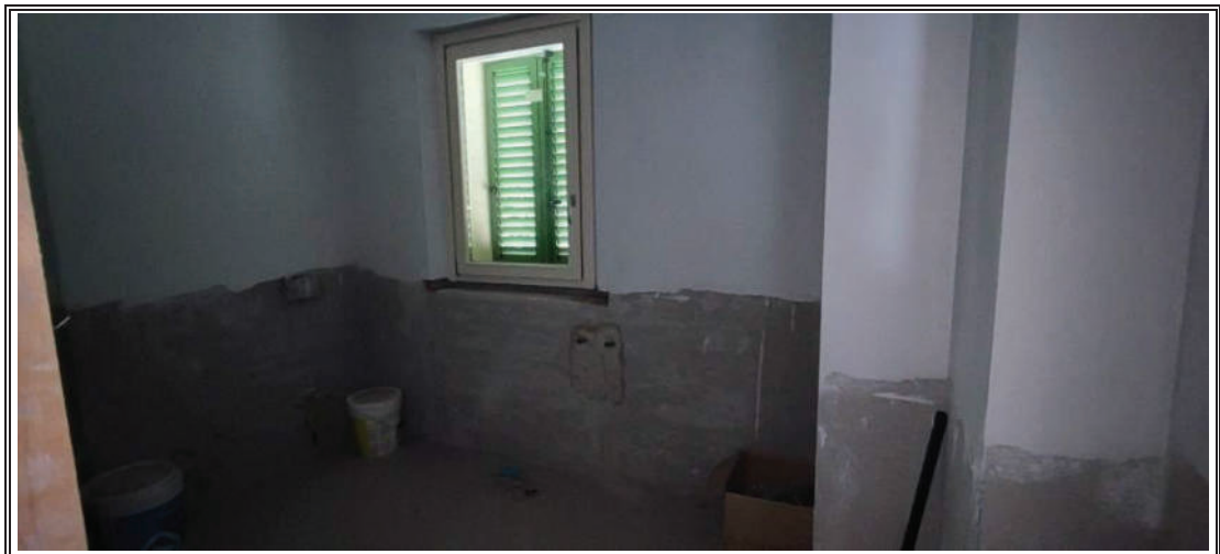
Foto n. 26 – Appartamento mapp. 1580 sub 3 – Bagno Piano terra
