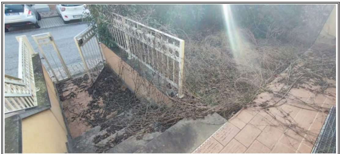
Foto n. 6 – Appartamento mapp. 1580 sub 2 – Corte lato strada
