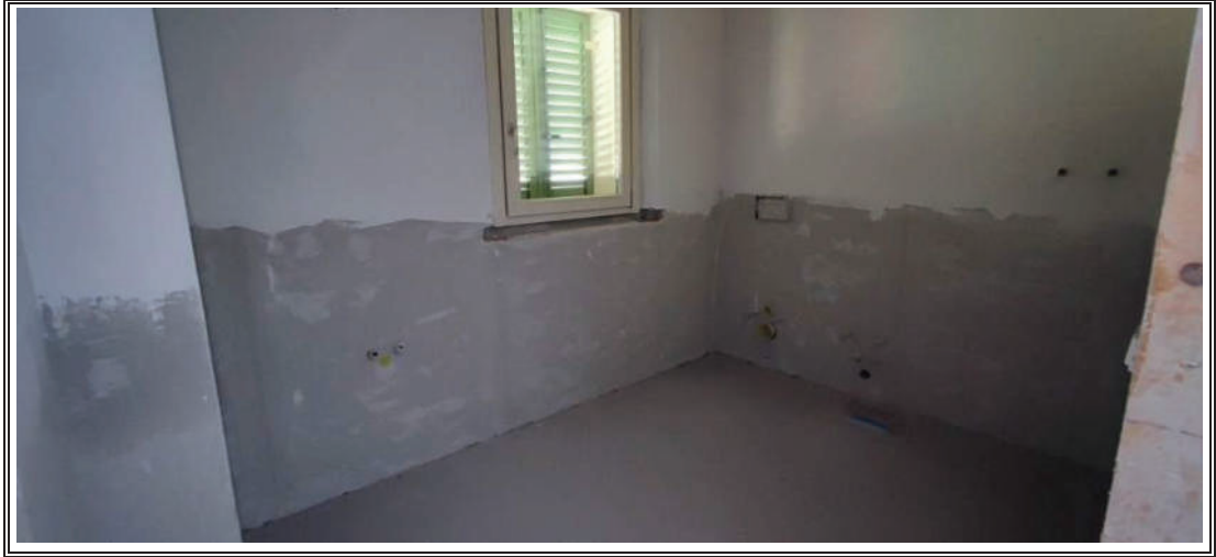
Foto n. 16 – Appartamento mapp. 1580 sub 2 – Bagno Piano primo
