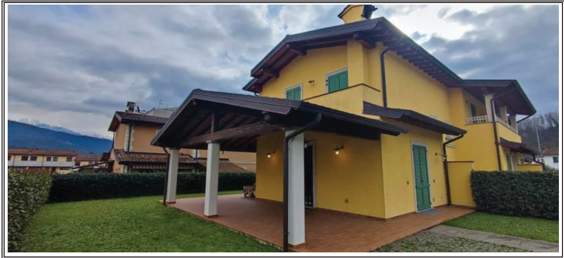
Foto n. 37 – Appartamento mapp. 1581 sub 12 – Angolo NORD VEST
