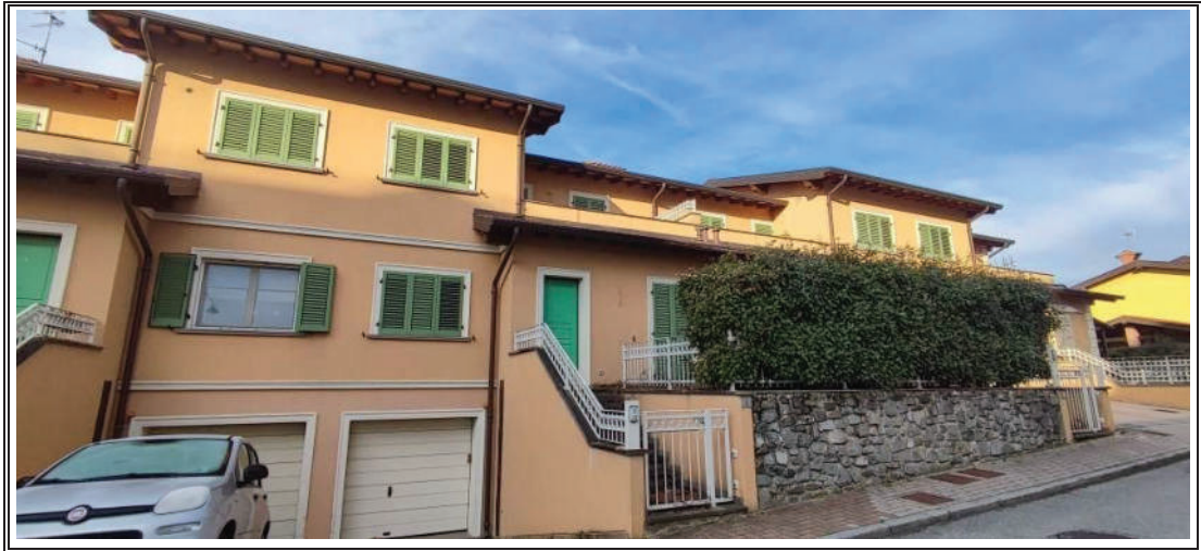
Foto n. 19– Appartamento mapp. 1580 sub 3 – Facciata EST
