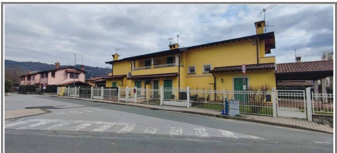
Foto n. 36 – Appartamento mapp. 1581 sub 12 – Fabbricato angolo SUD OVEST
