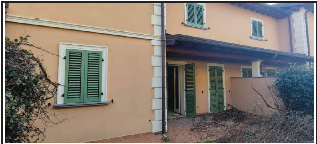
Foto n. 5 – Appartamento mapp. 1580 sub 2 – Facciata OVEST
