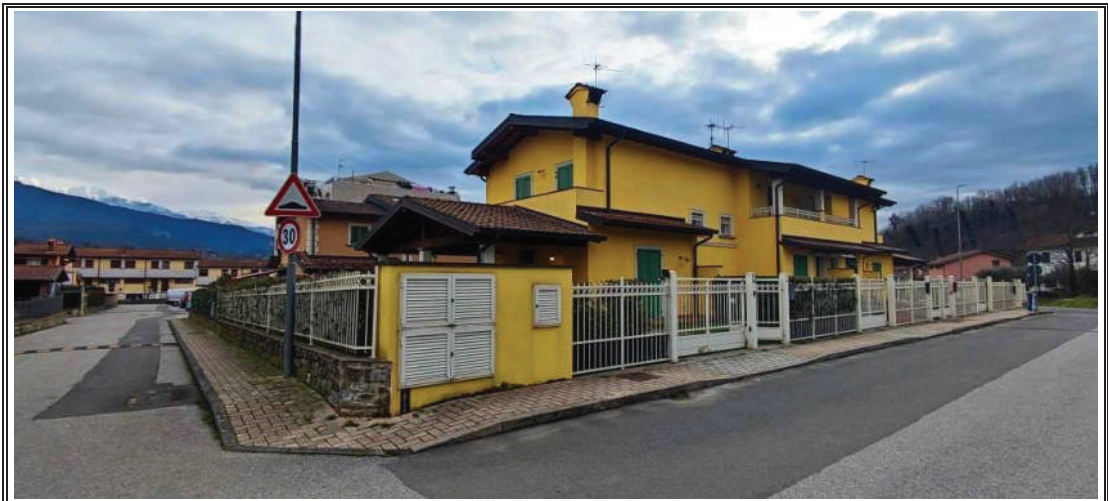
Foto n. 35 – Appartamento mapp. 1581 sub 12 – Fabbricato angolo NORD OVEST
