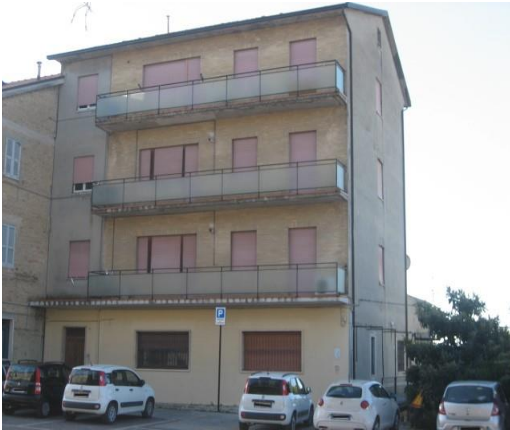
FOTO 1 - Prospetto nord Condominio via IV Novembre 33, P.T. finestre negozio angolo destro
