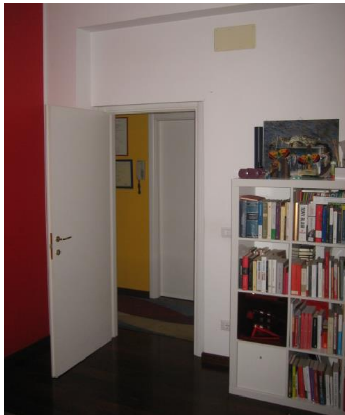
FOTO n. 6 – Porta interna comunicante con altra proprietà
