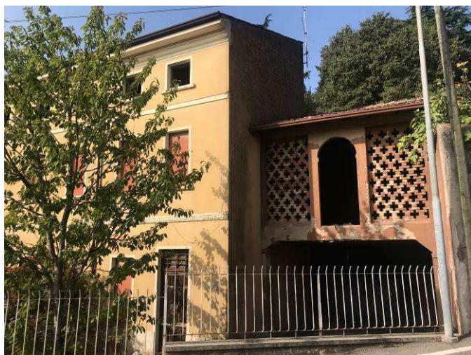
Lotto D edificio Solferino
