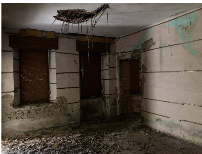
Lotto D edificio Solferino
