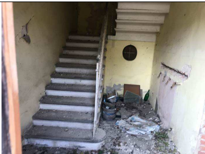
Lotto D edificio Solferino
