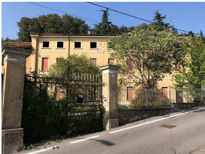
Lotto D edificio Solferino
