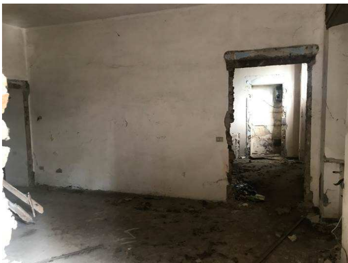
Lotto D edificio Solferino
