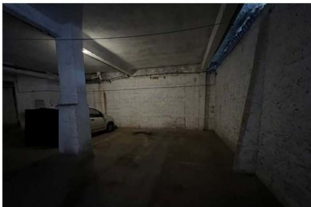
Foto 14. Vista seminterrato (posto auto)
