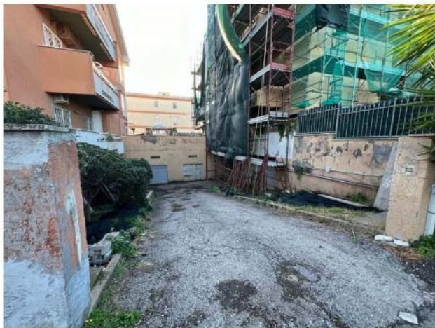
Foto 13. Vista esterna (rampa accesso posto auto)
