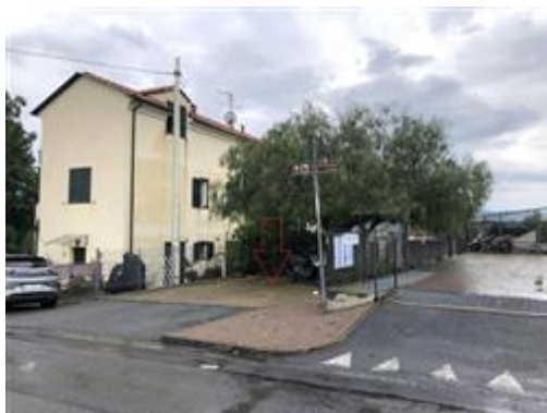
Fabbricato di civile abitazione mappale 528 condominio I Pini - vista esterna generale da via Cavour
