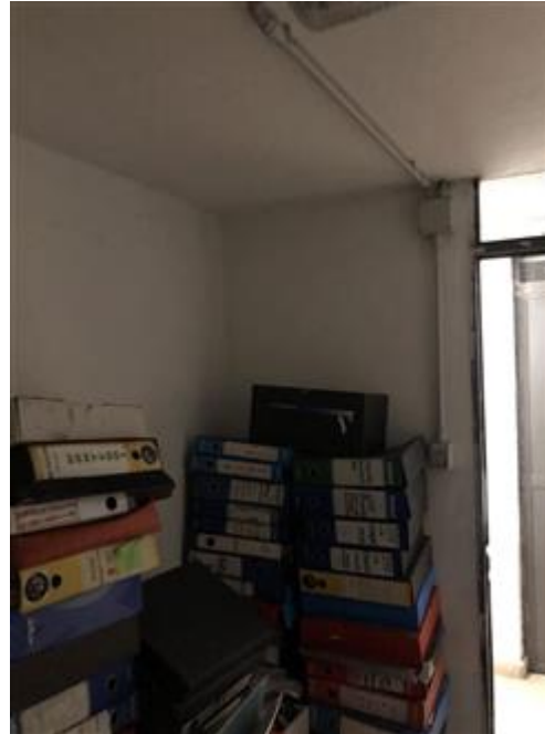
Vista interna locale cantina
