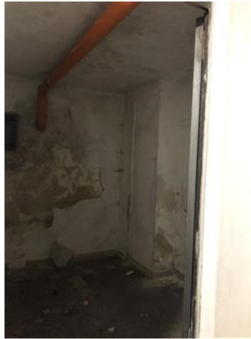
Vista interna locale cantina
