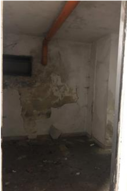
Vista interna locale cantina
