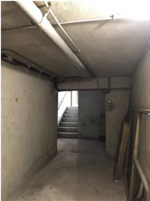
Vista accesso e corridoio distribuzione cantine
