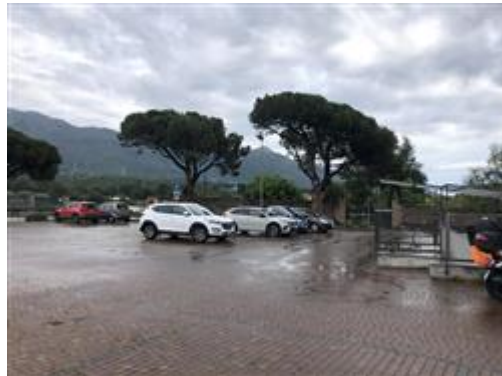
Area a parcheggio vista generale
