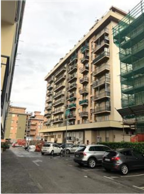
Complesso di civile abitazione Condominio Panorama A - vista da corte interna - lato monte
