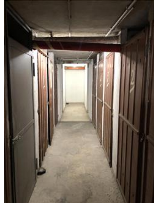
Corridoio di distribuzione cantine
