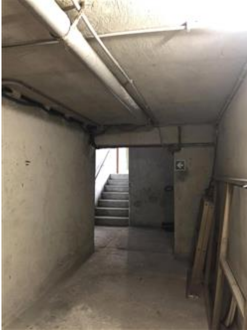
Vista accesso e corridoio distribuzione cantine
