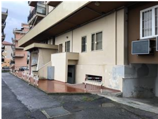
Vista corte e accesso al magazzino piano seminterrato
