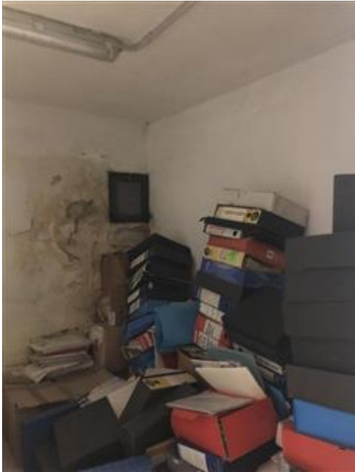
Vista interna locale cantina
