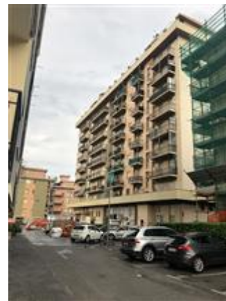
Complesso di civile abitazione Condominio Panorama A - vista da corte interna - lato monte
