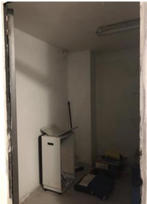
Vista interna locale cantina
