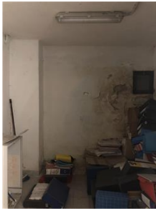
Vista interna locale cantina
