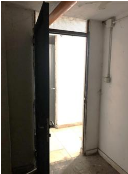
Vista interna locale cantina
