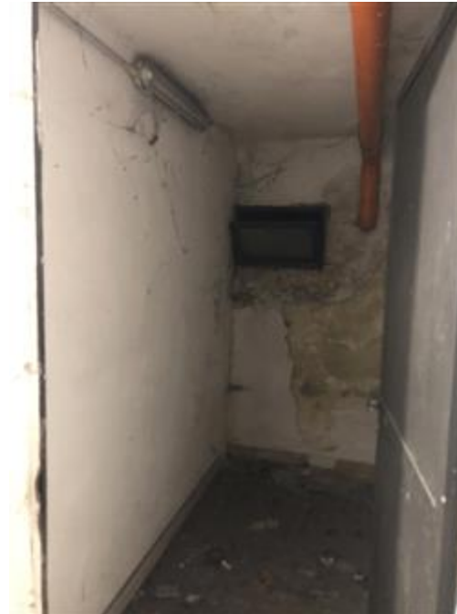
Vista interna locale cantina
