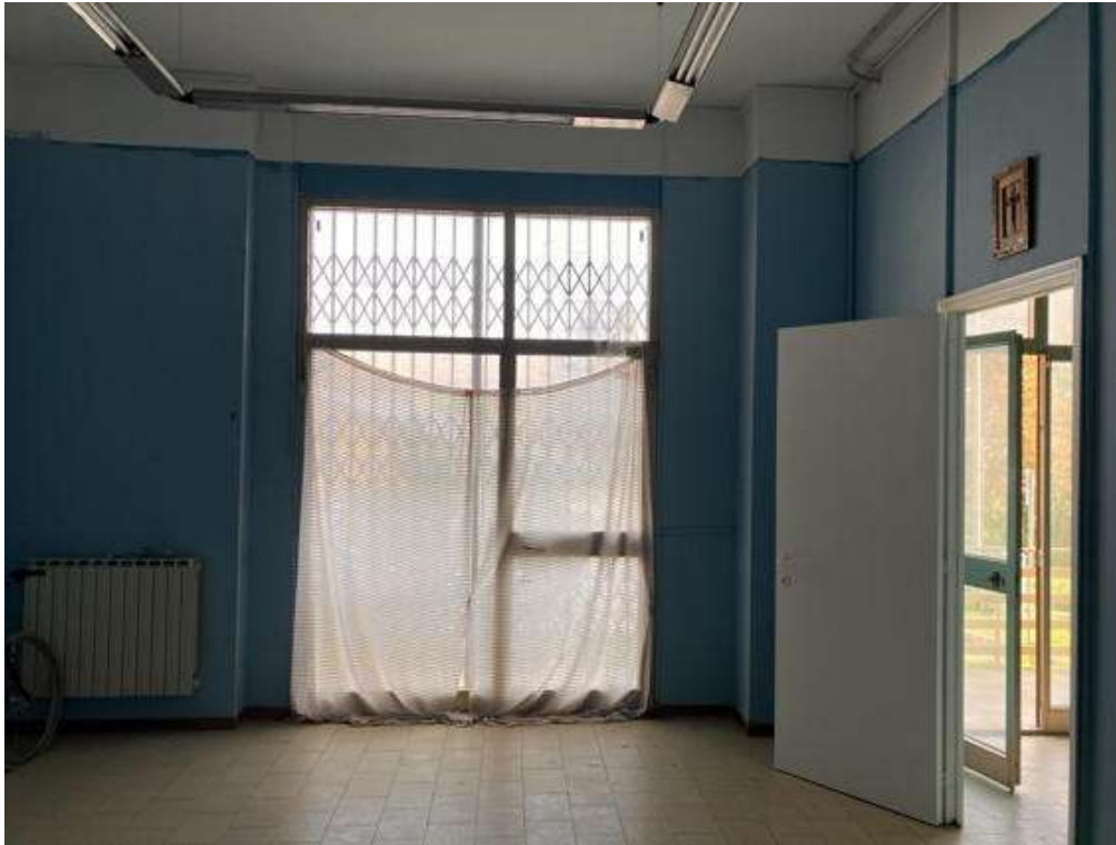
Fotografia F.39 - Piano terra - magazzino
