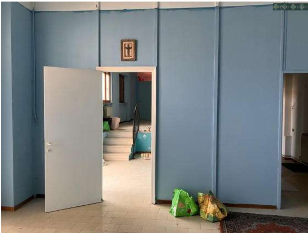
Fotografia F.38 - Piano terra - magazzino
