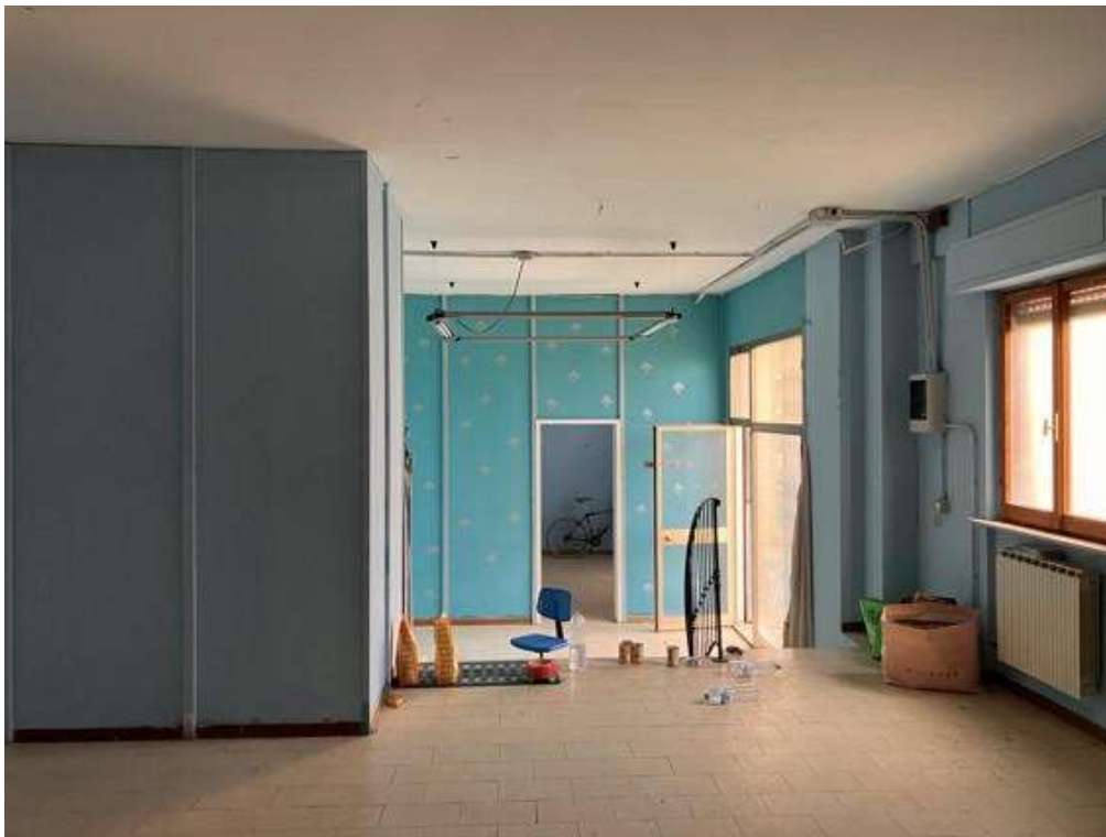
Fotografia F.42 - Piano terra - magazzino
