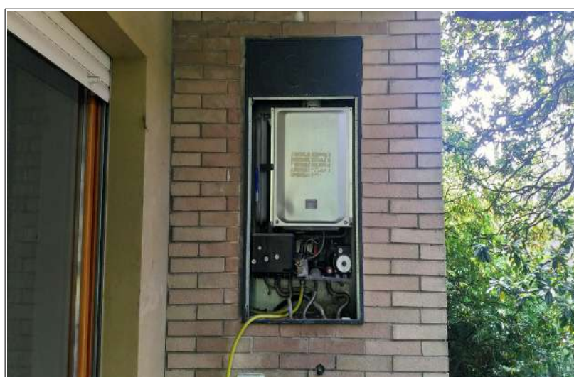
La nicchia della caldaia posta sul balcone che dovrà essere oggetto di demolizione
