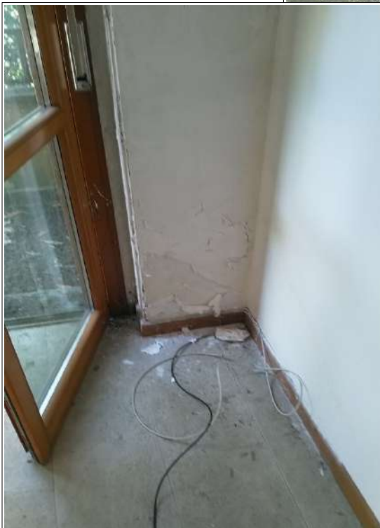
Particolare del distacco della finitura in una porzione del soggiorno causa infiltrazione da cassonetto
