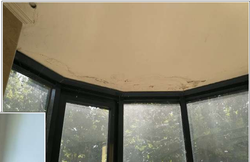
Particolare del distacco della finitura in una porzione del soggiorno causa infiltrazione da cassonetto
