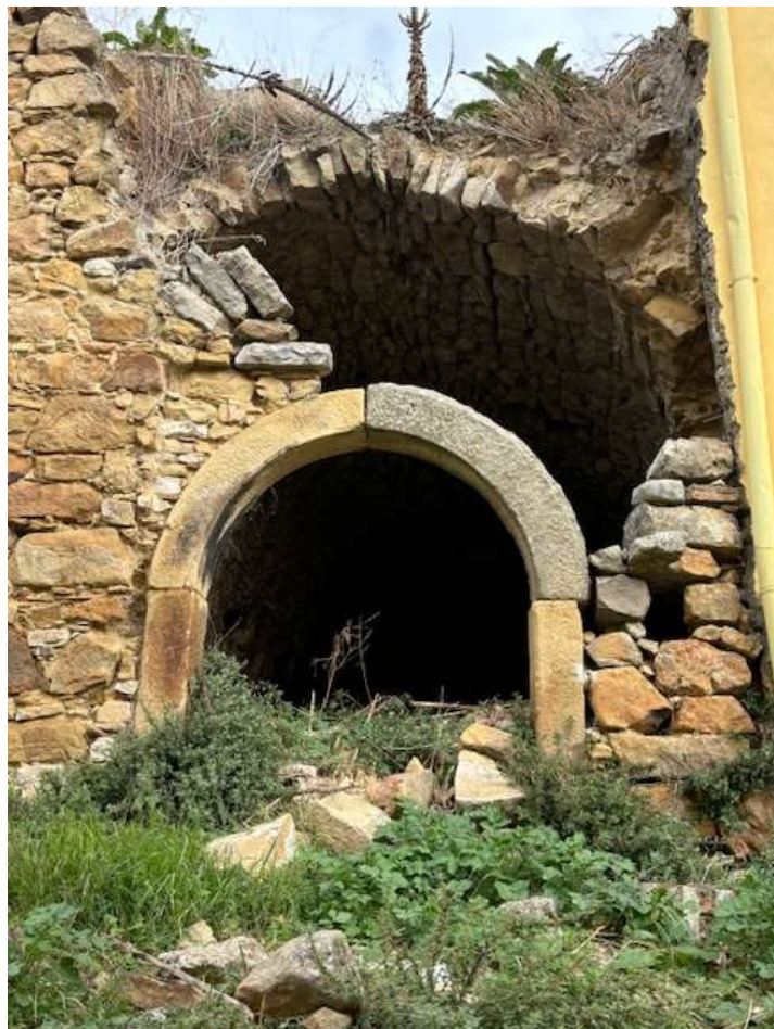
Foto n. 14 – Particolari del locale deposito
