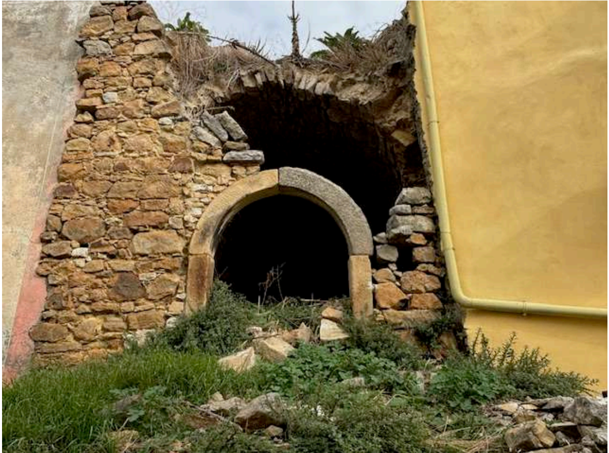
Foto n. 13 – Prospetto su Via degli Orti del locale deposito
