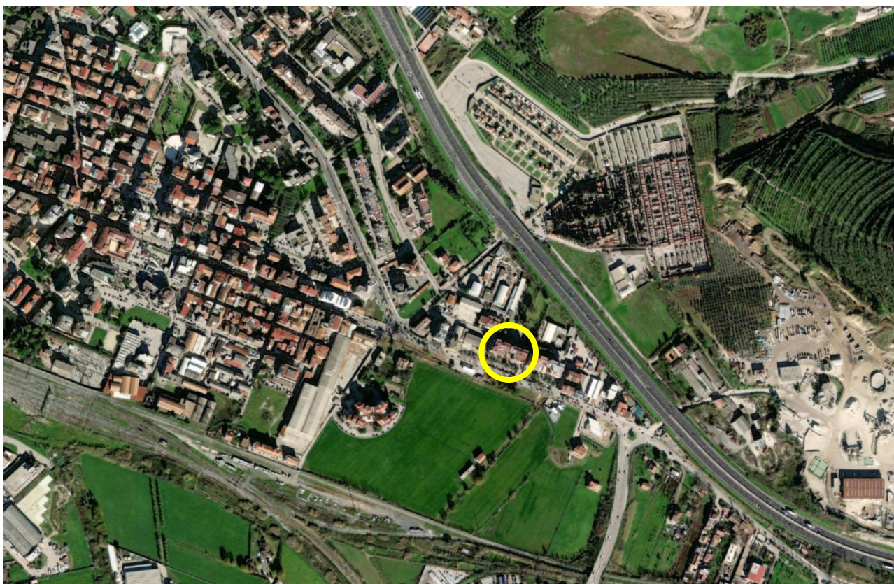
Identificazione immobile su ortofoto – (fonte: geoportale)
