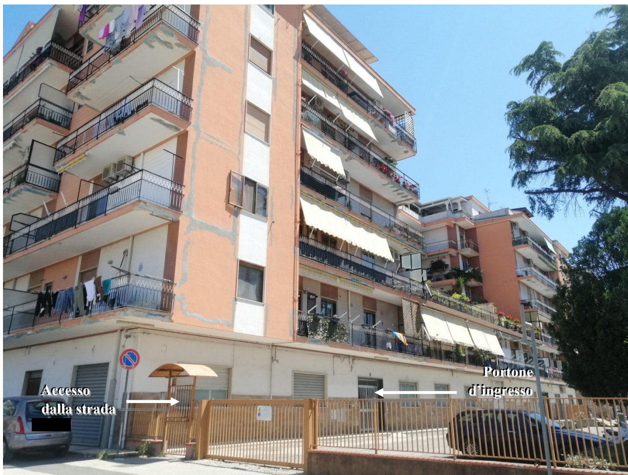
Foto esterna del Fabbricato
