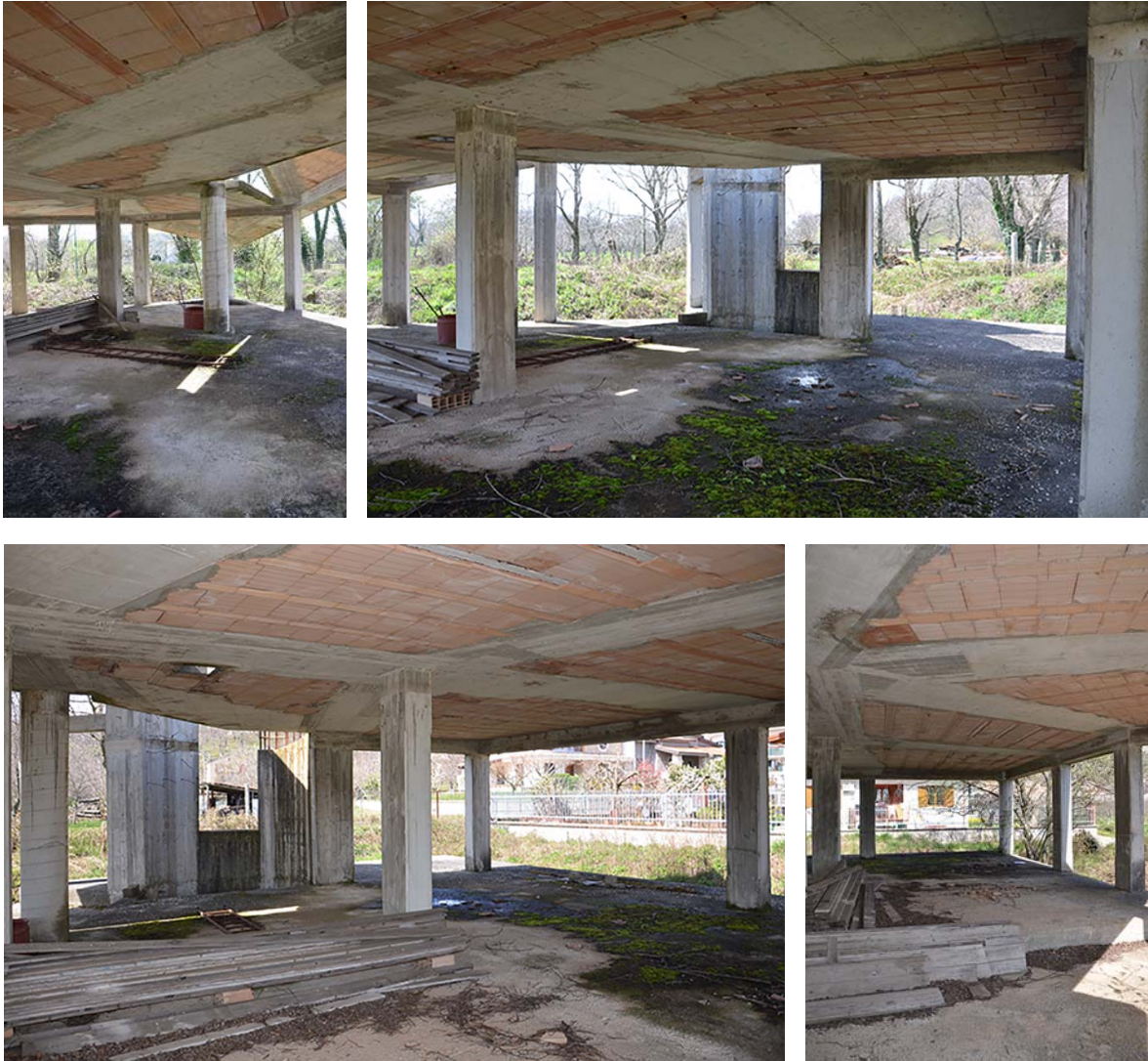
_viste interne piano terra
