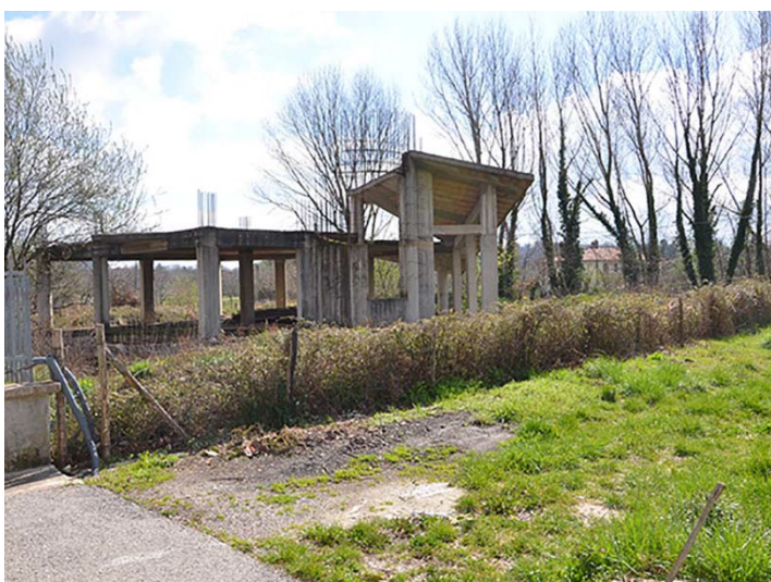
_viste dalla strada da completare
