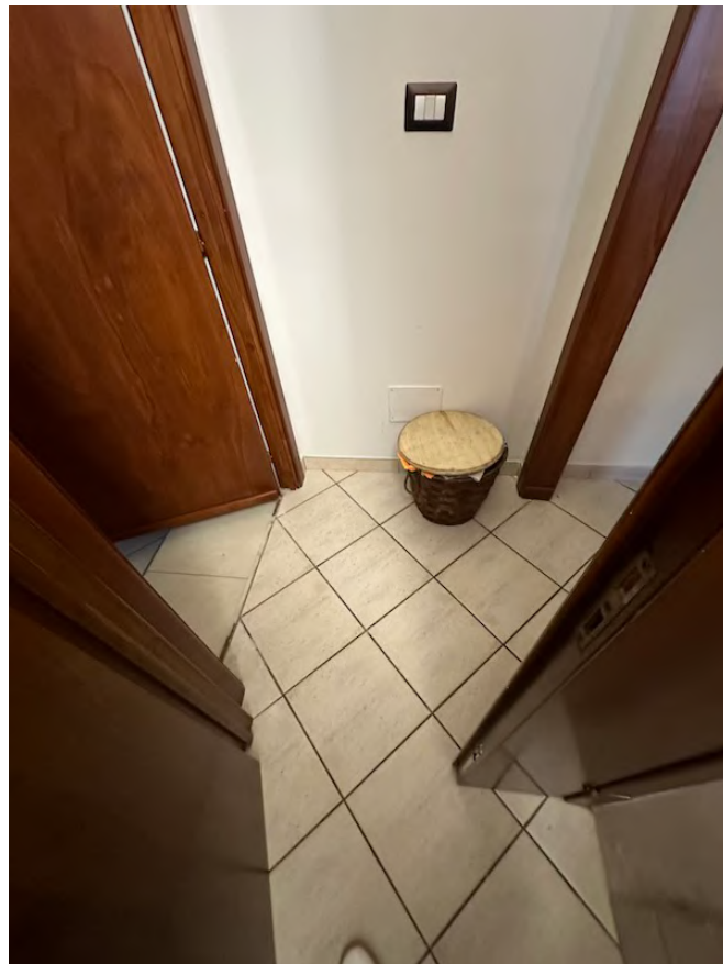
foto n.º4 – particolare disimpegno
