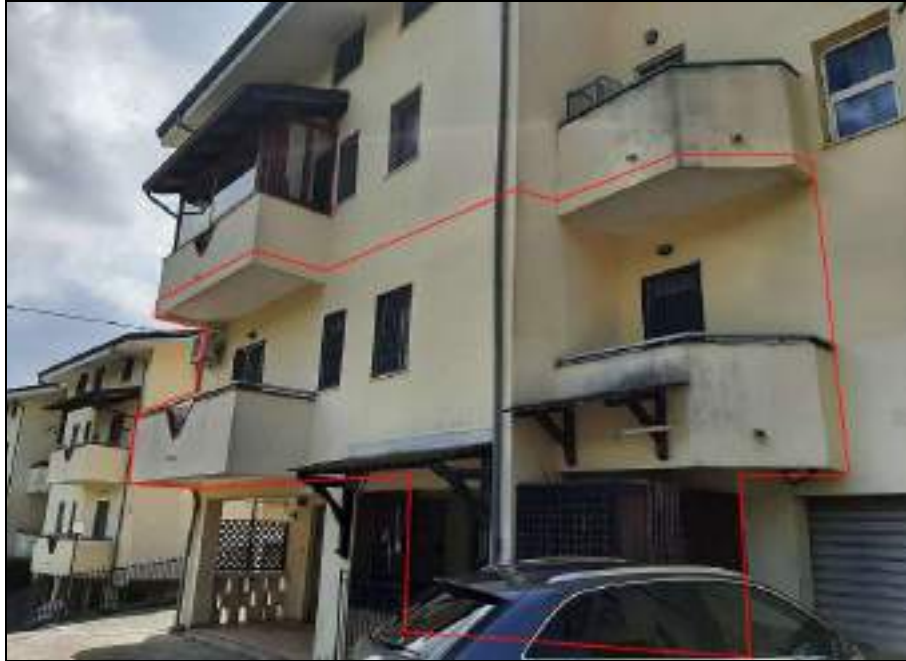
Vista Immobile parete lato nord
