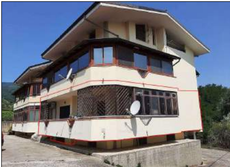
Vista Immobile pareti lato est e lato sud
