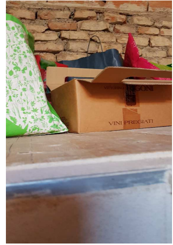
14 – Isolamento del sottotetto
