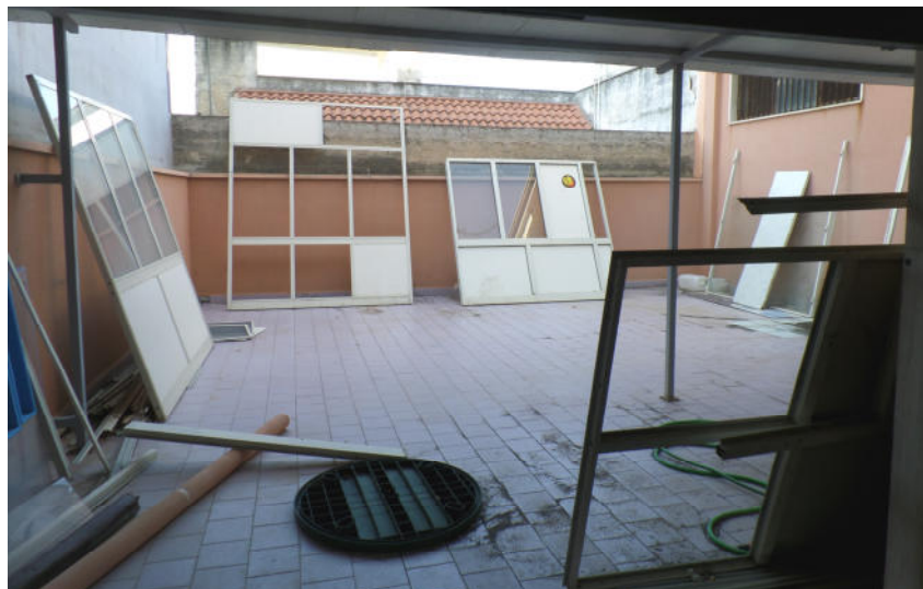
Foto n° 2.7 Cortile pertinenziale: vista dall'interno
