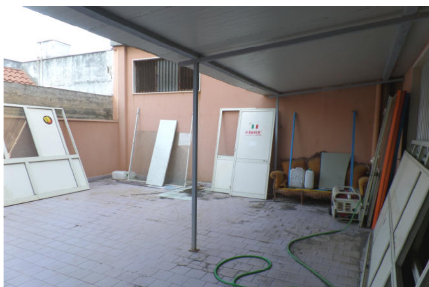
Foto n° 2.9 Cortile pertinenziale: vista laterale
