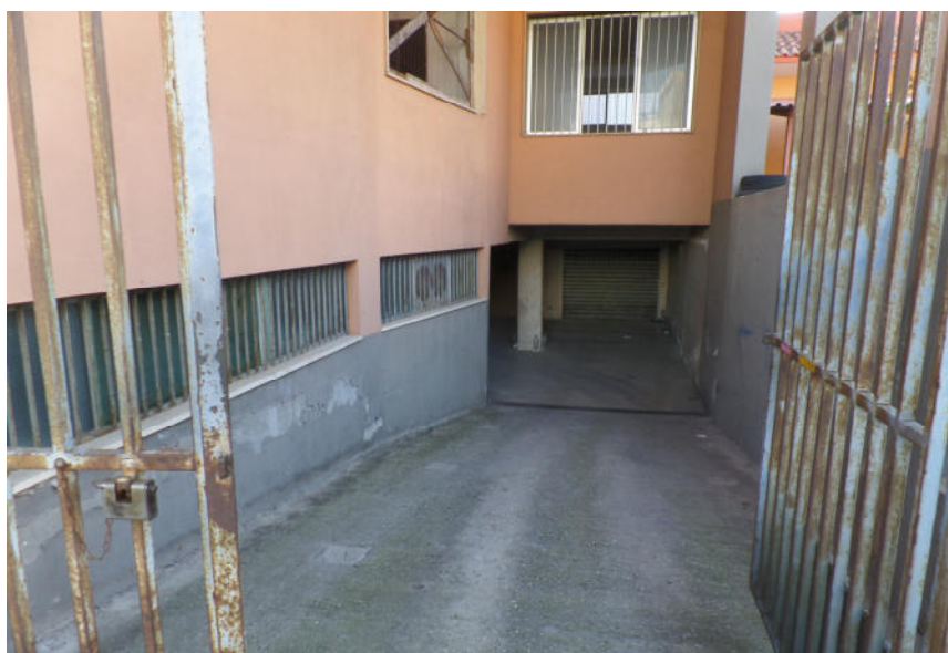
Foto n° 1.3 Via Salvatore Quasimodo: ingresso al Piano seminterrato
