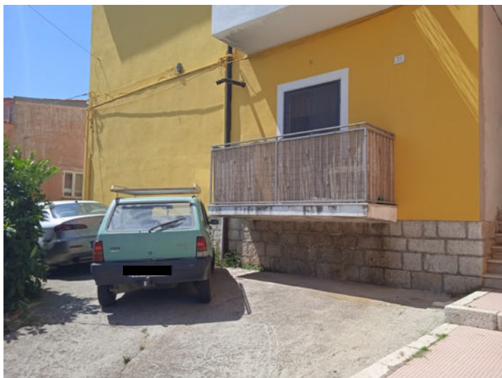
Foto n. 25 – Part. 662 sub 1 - Vista balcone
