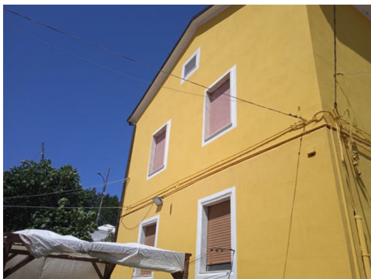
Foto n. 6 – Vista esterna fabbricato
