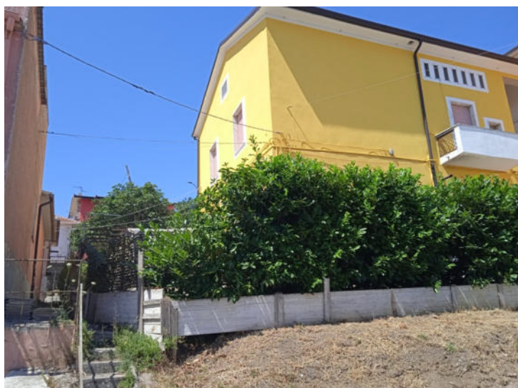
Foto n. 5 – Vista esterna fabbricato
