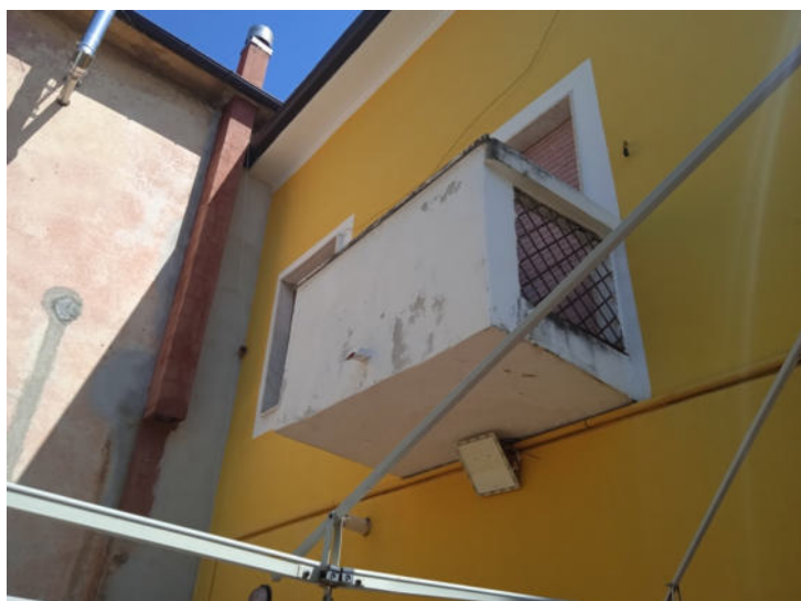
Foto n. 7 – Vista esterna fabbricato
