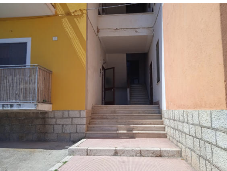
Foto n. 8 – Vista androne fabbricato
