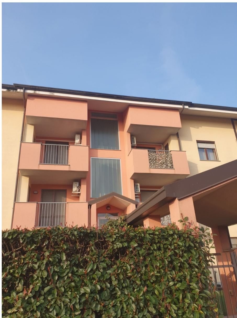
Vista dell'esterno del fabbricato
