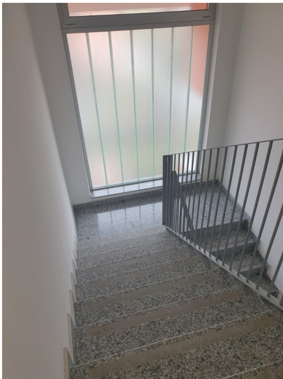
Vista del vano scala condominiale
