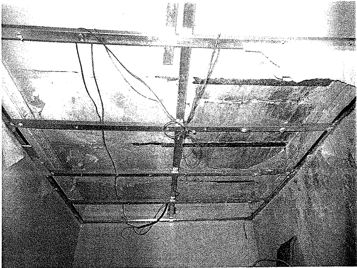
FO- 19- VISTA DELLA STRUTTURA DEL CONTROSOFFITTO DELLA STANZETTA
