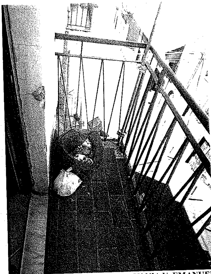
FO-9-BALCONE DELLA CUCINA SU VIA V. EMANUELE
