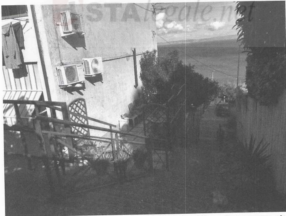
Foto N°2. Vista della facciata laterale Sx del fabbricato e della scalinata comune, che parte dalla sottostante Via Del Sole.
