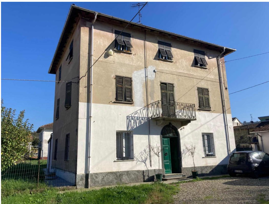
Foto 1 – Prospetto ovest ingresso
