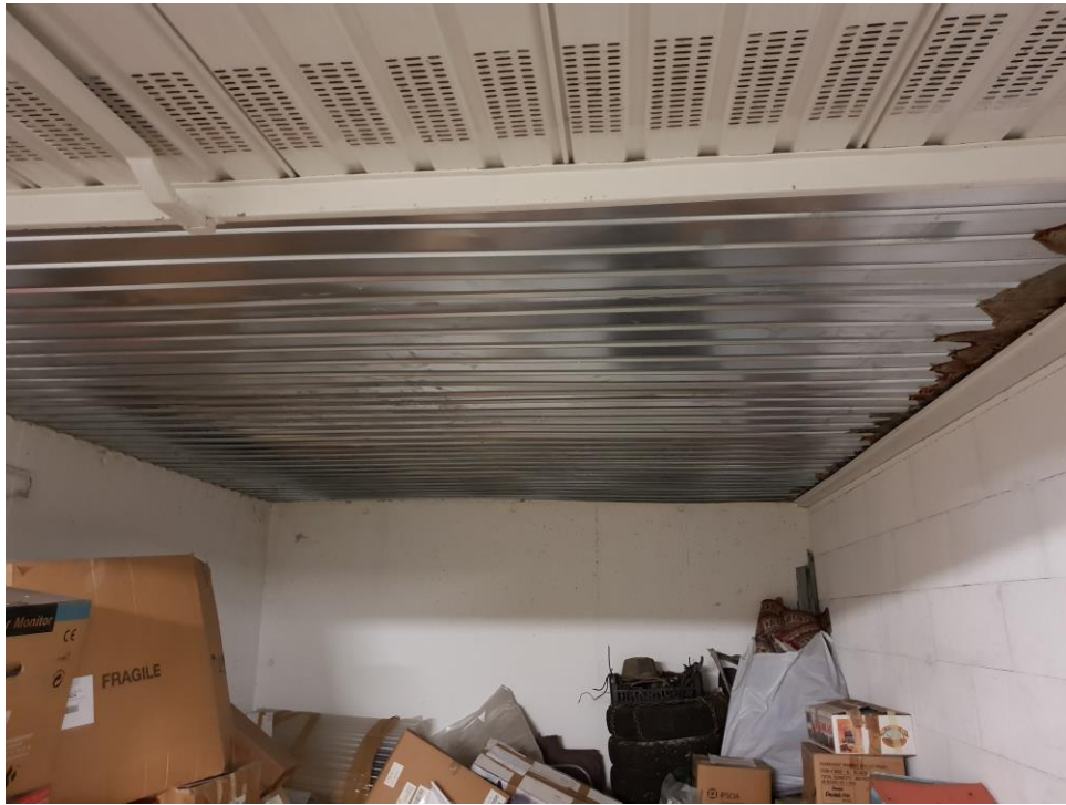
Foto n° 41 – particolare controsoffitto in lamiera
