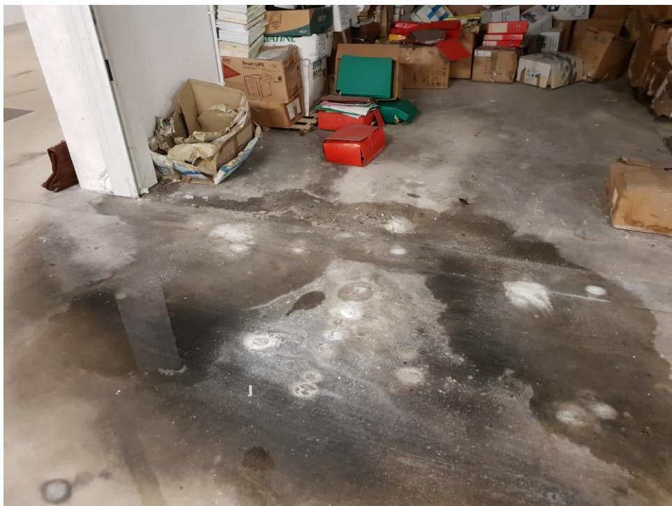
Foto n° 40 – particolare infiltrazioni
