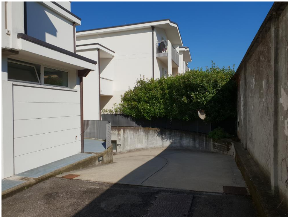
Foto n° 34 – vista rampa di accesso alle autorimesse
