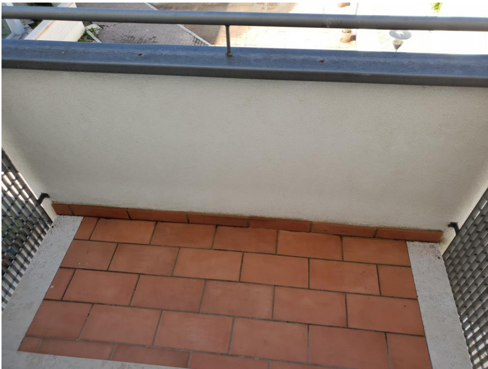
Foto n° 18 – particolare pavimentazione terrazzino a sud
