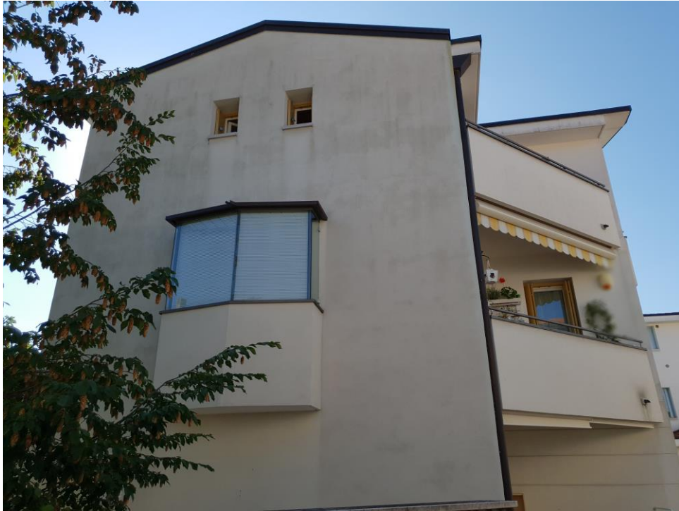
Foto n° 5 – vista da nord-ovest
