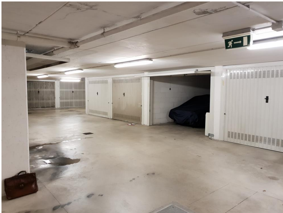
Foto n° 42 – vista area comune di manovra e autorimessa sub 139
