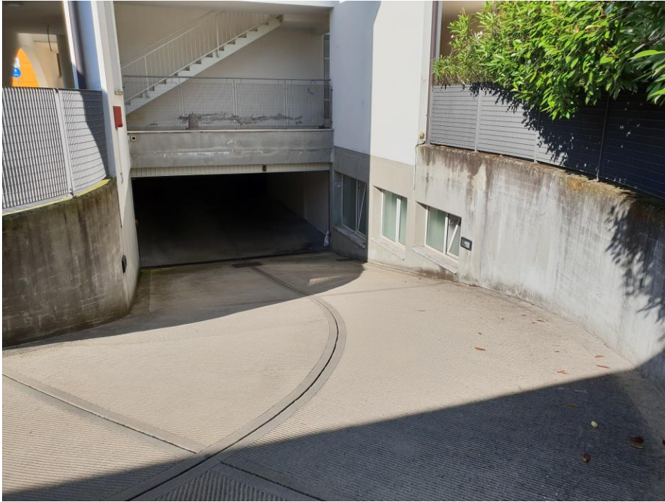
Foto n° 35 – vista rampa di accesso alle autorimesse
