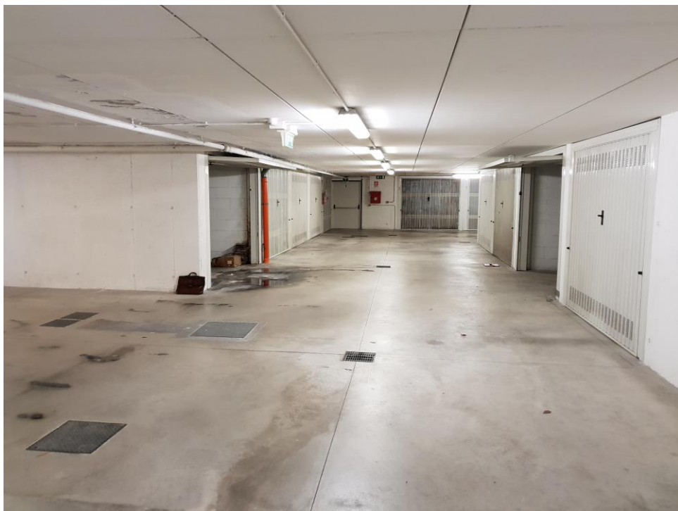
Foto n° 38 – vista area comune di manovra
