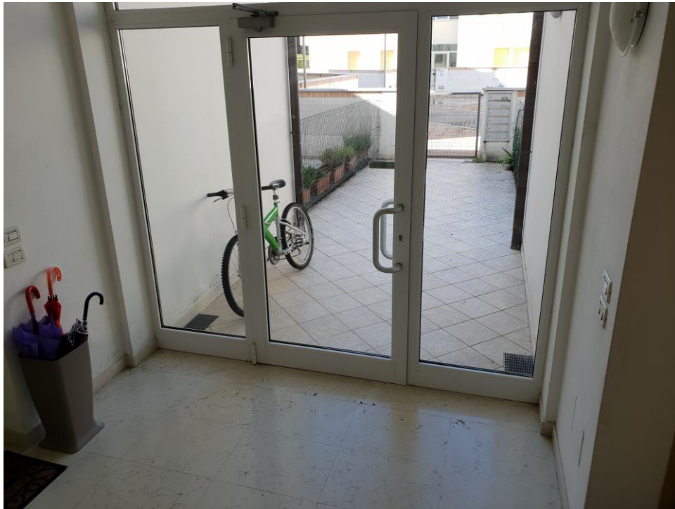
Foto n° 11 – vista del vano scala comune
