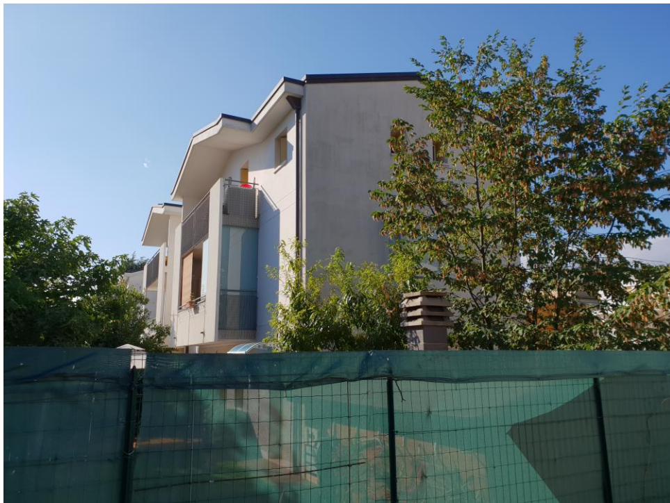
Foto n° 6 – vista da nord
