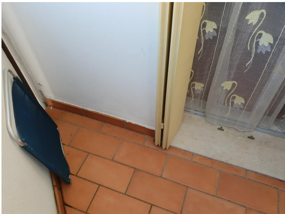
Foto n° 30 – particolare pavimentazione terrazzo a ovest
