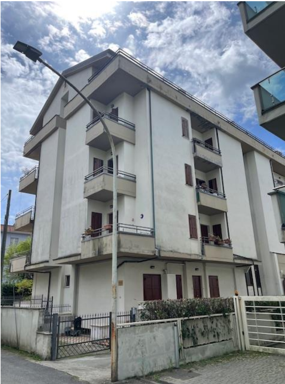
Vista dell'intero fabbricato
