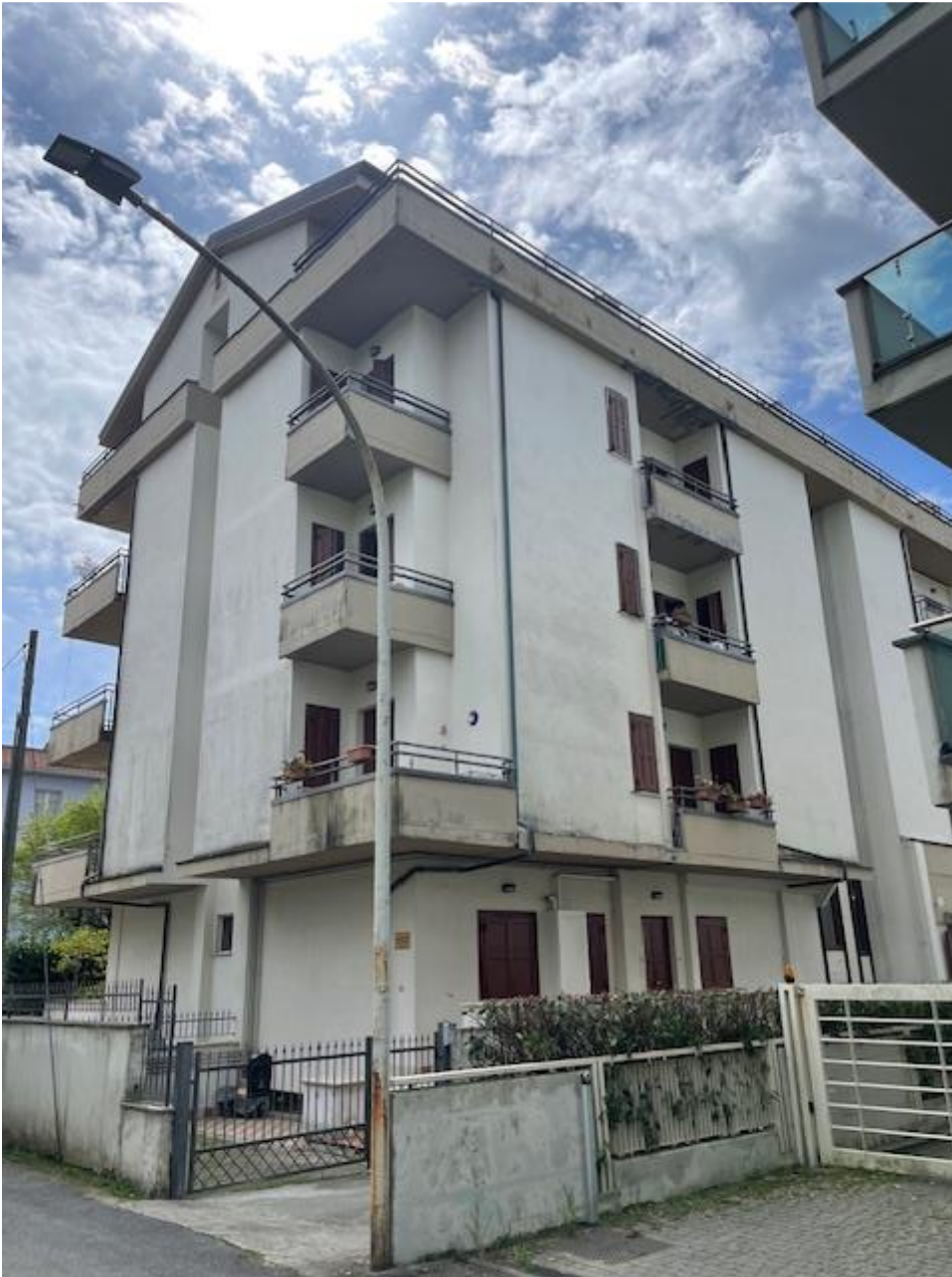
Vista dell'intero fabbricato
