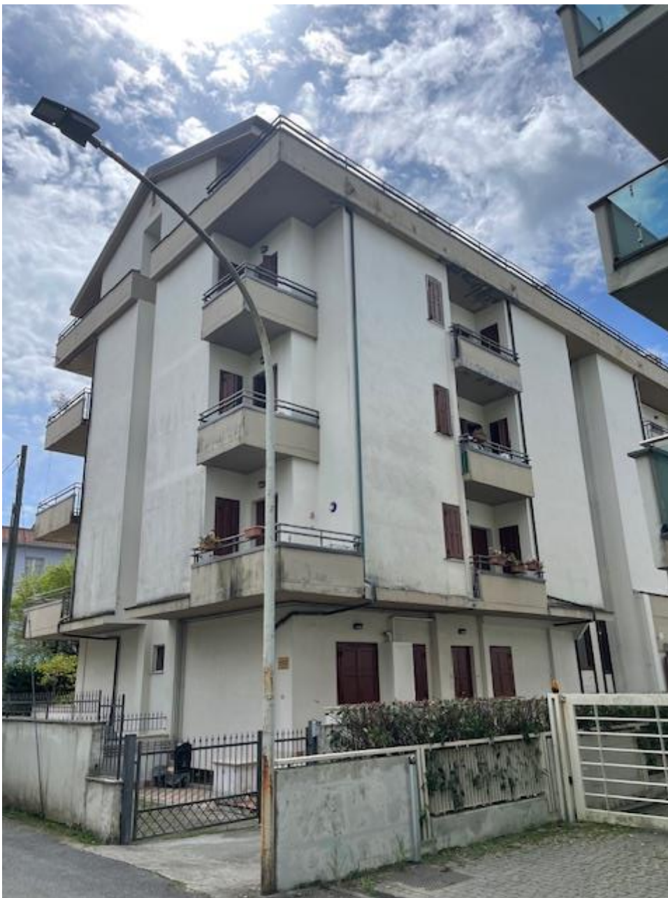
VISTA DELL'INTERO FABBRICATO
