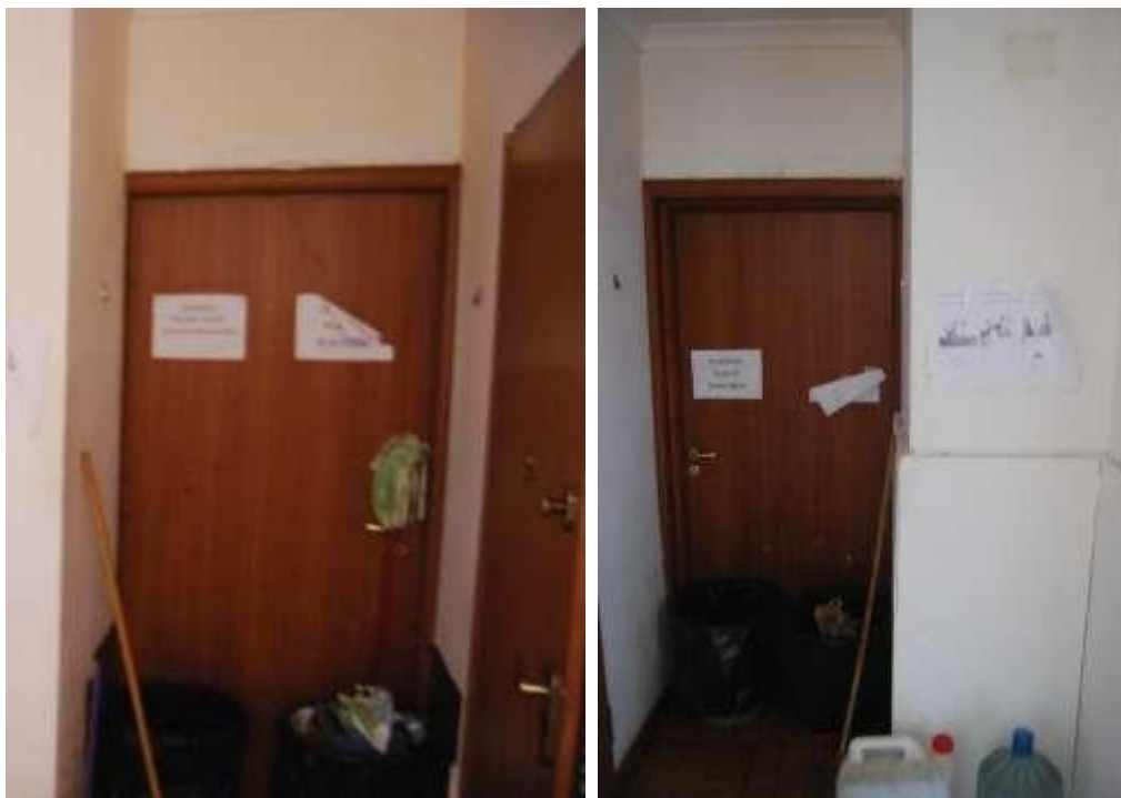
Foto 11. Porta vista dal sub 31
