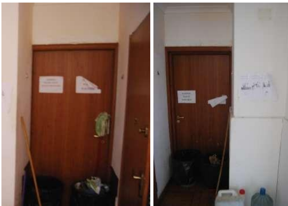
Foto 5. Porta vista dal sub 31
