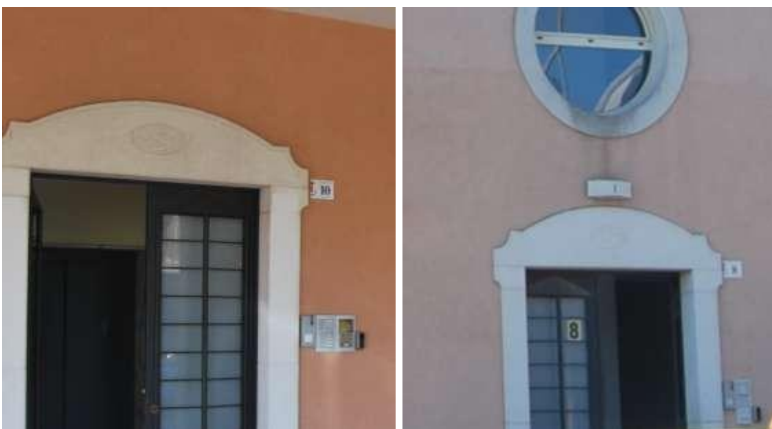
Foto 1. Corpo Scala “A” e Corpo Scala “B”
