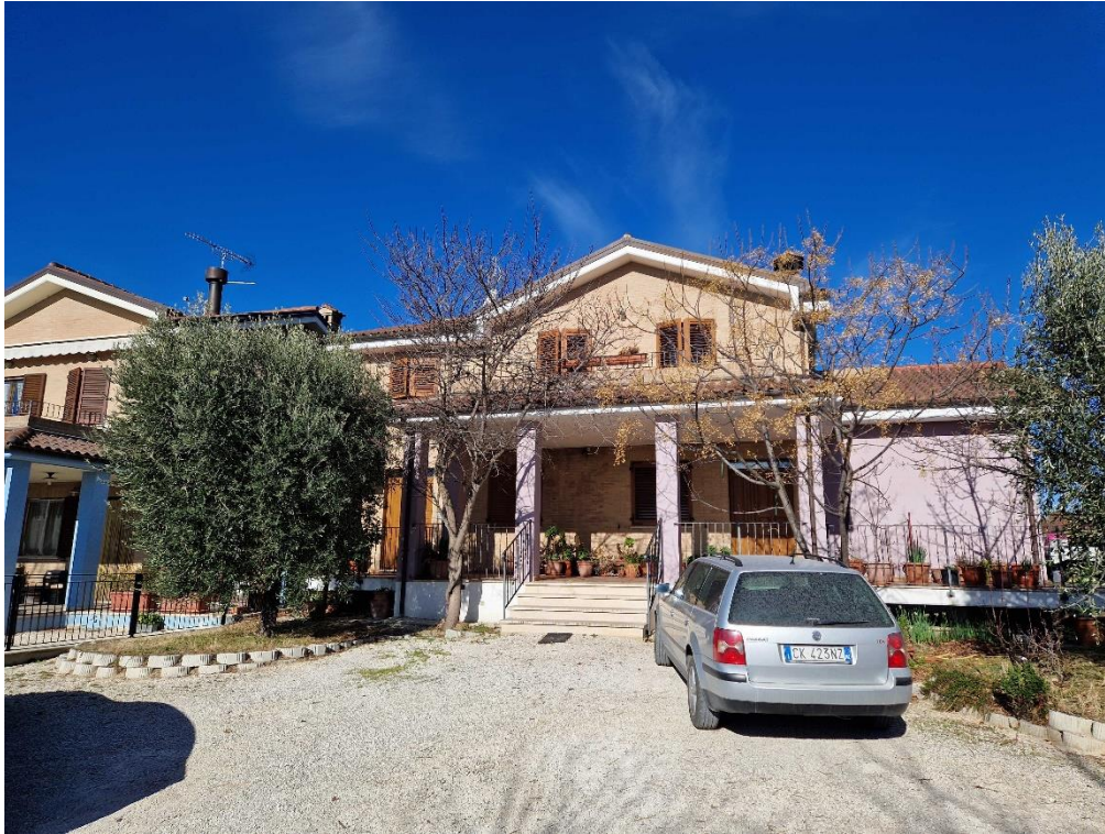
FOTO 1 – Vista generale del fabbricato
