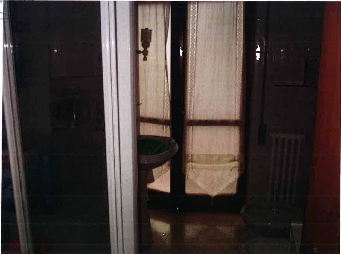
FOTO n. 11 – locali piano terra
