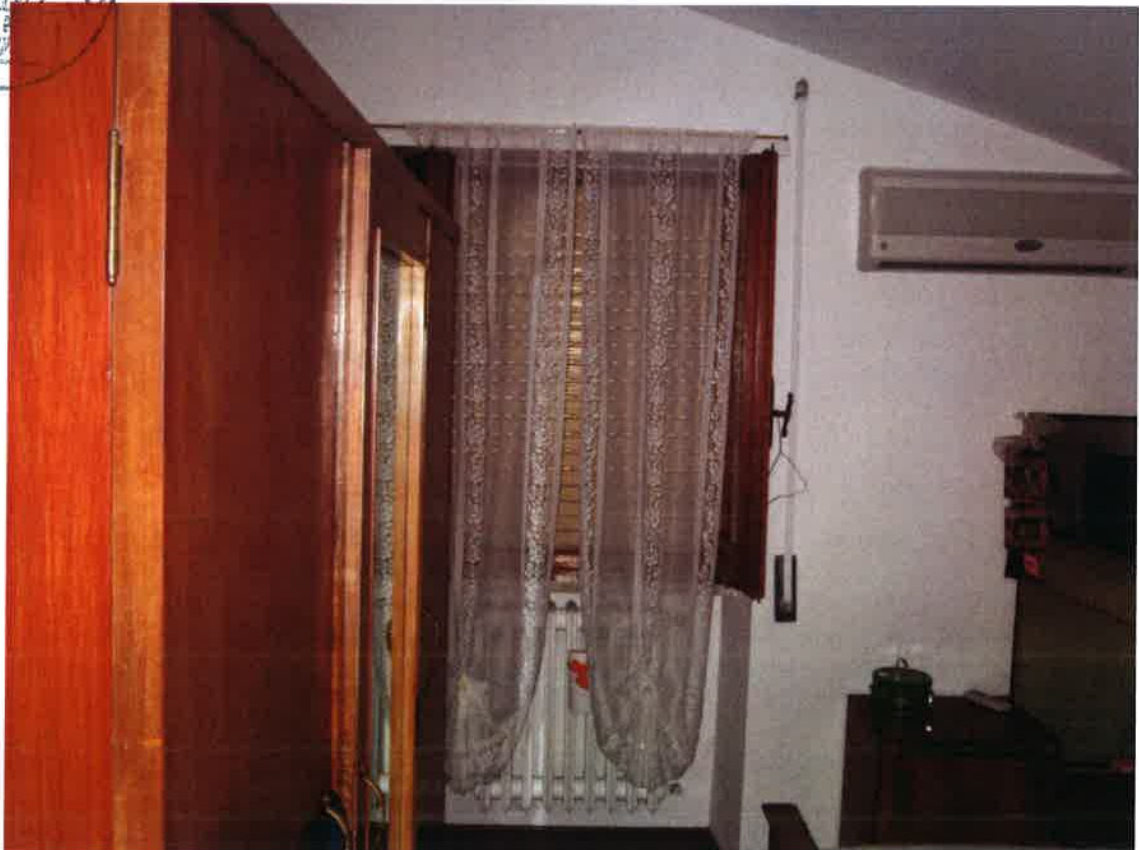
FOTO n. 19 – locali piano primo
