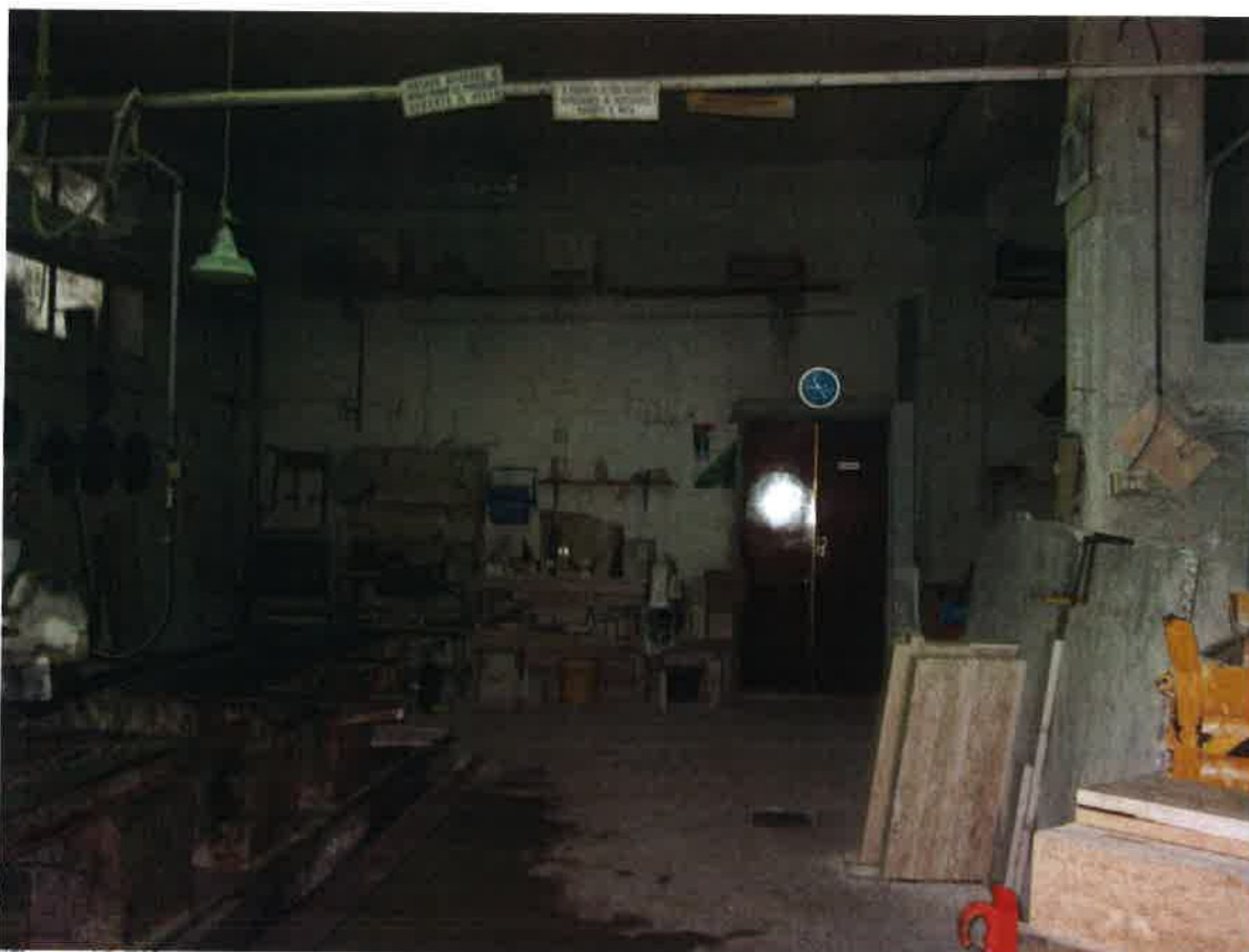
FOTO n. 6 – locali piano seminterrato
