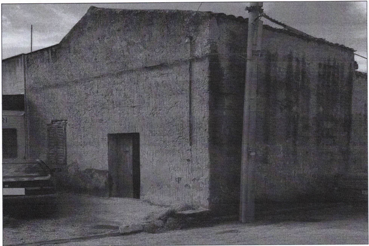
Foto 1: Panoramica esterna – prospetto principale fabbricato via Marsala n.392 – C.da Rilievo - Trapani
