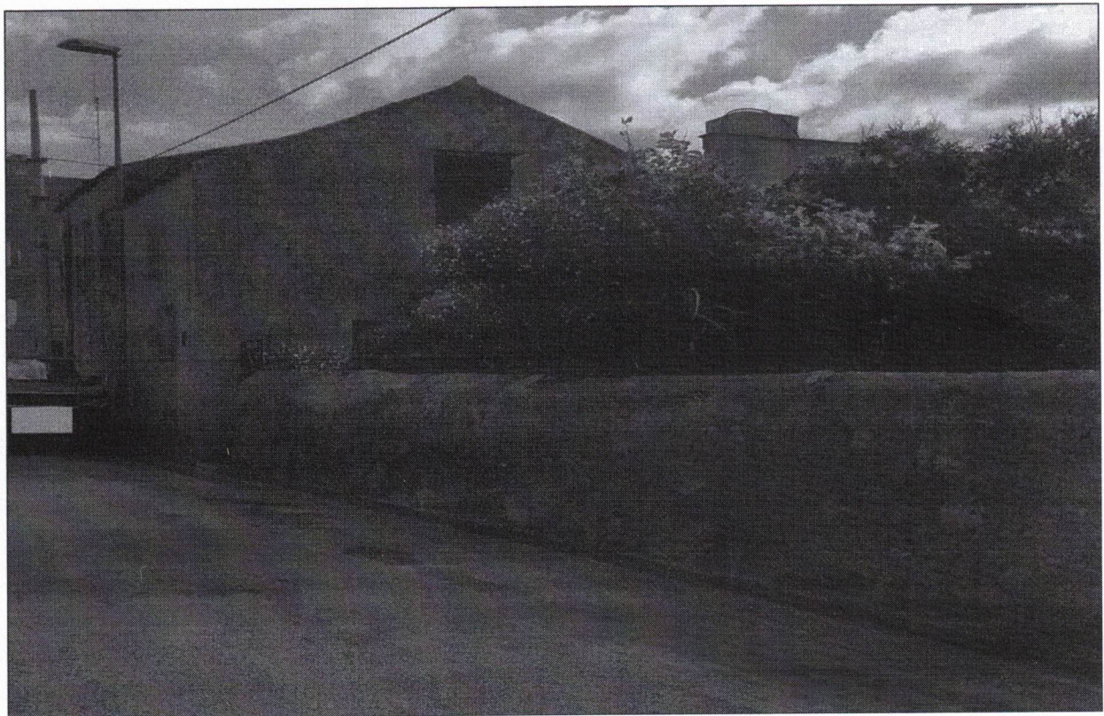
Foto 2: Panoramica lato posteriore fabbricato via Marsala n.392 – C.da Rilievo - Trapani
