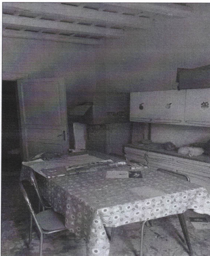
Foto 3: Particolare vano ingresso-pranzo fabbricato via Marsala n.392 – C.da Rilievo - Trapani
