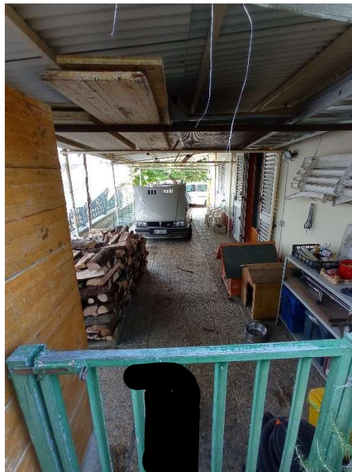
Vista Corte Sud – Tettoia da demolire
