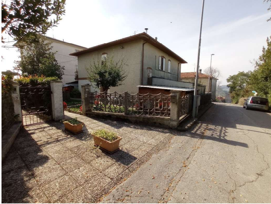
Vista Nord-Est – Ingresso Pedonale
