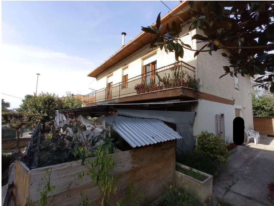
Vista Sud-Ovest – tettoia da demolire
