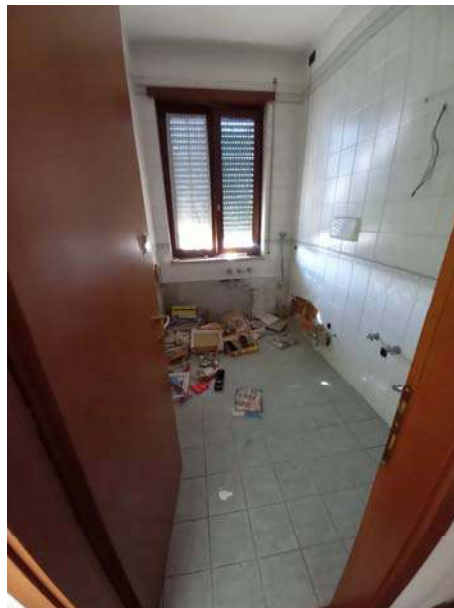
VISTA BAGNO 2P
