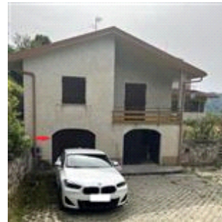
Panoramica box auto
