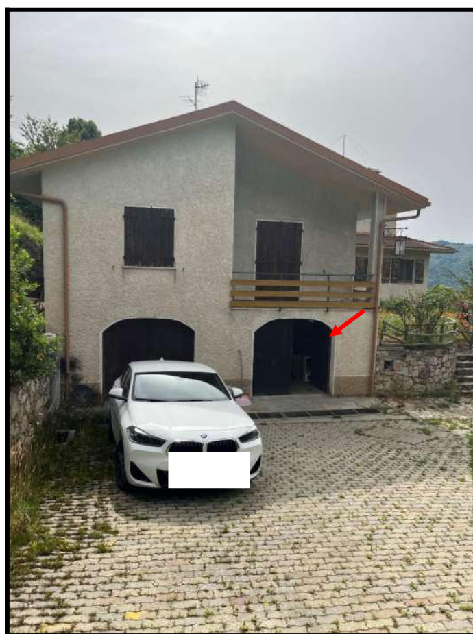
Foto 12 – Panoramica ingresso box auto accessorio CORPO A
