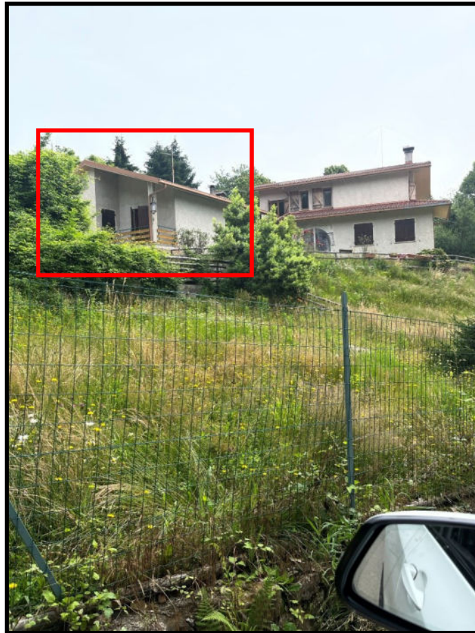
Foto 1 – Panoramica fabbricato con indicazione dell'appartamento del CORPO A
