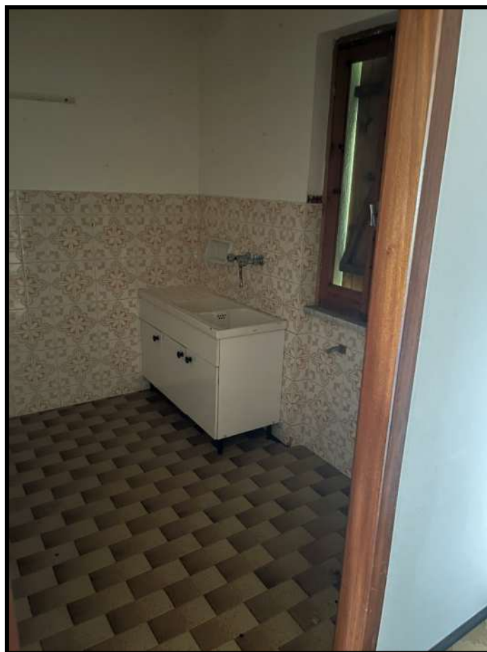
Foto 7 - Particolare cucina appartamento Corpo A
