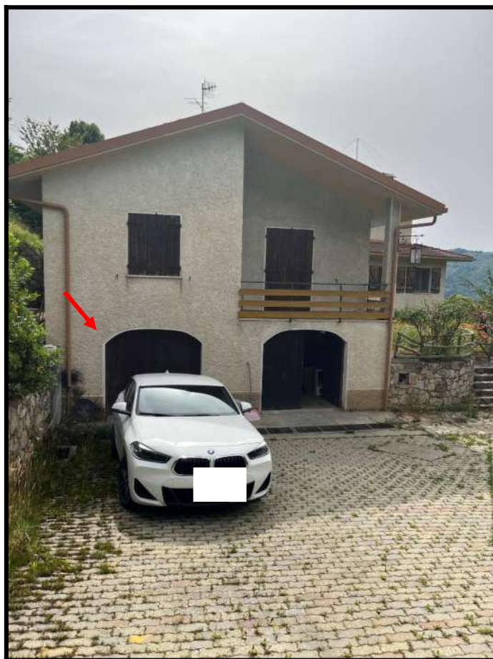
Foto 27 – Panoramica accesso box auto accessorio Corpo B
