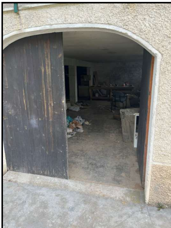
Foto 28 – Particolare ingresso box auto accessorio Corpo B
