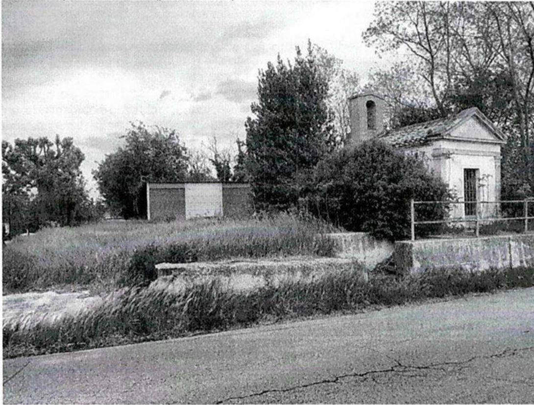
Rimessa Agricola con corte (particella 345)
