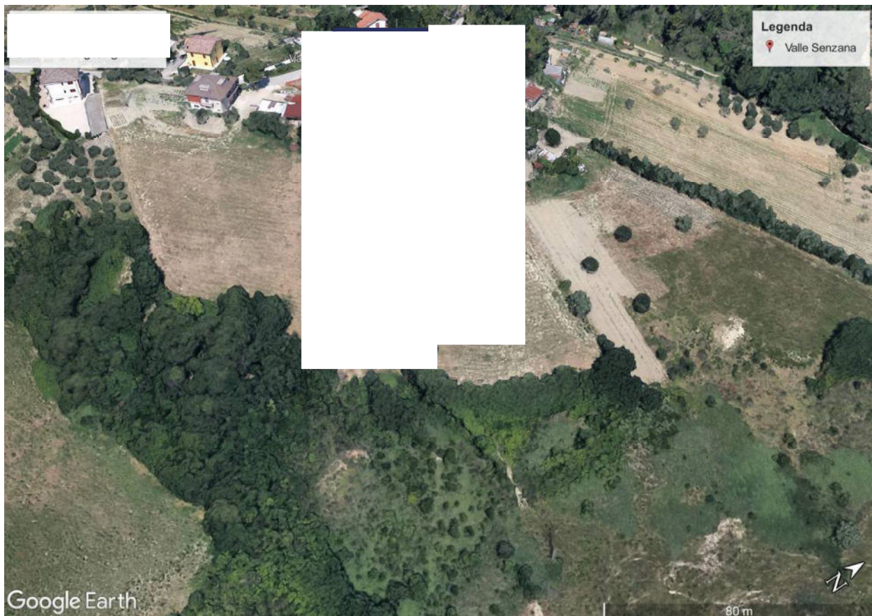
Fig.4 – Immagine presa da Google Earth relativa ad una foto aerea. La freccia indica il fabbricato, la linea l'area di dissesto.
