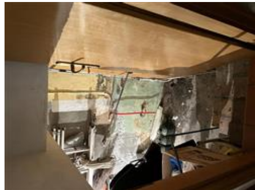
scala interna di collegamento ai piani interrati
