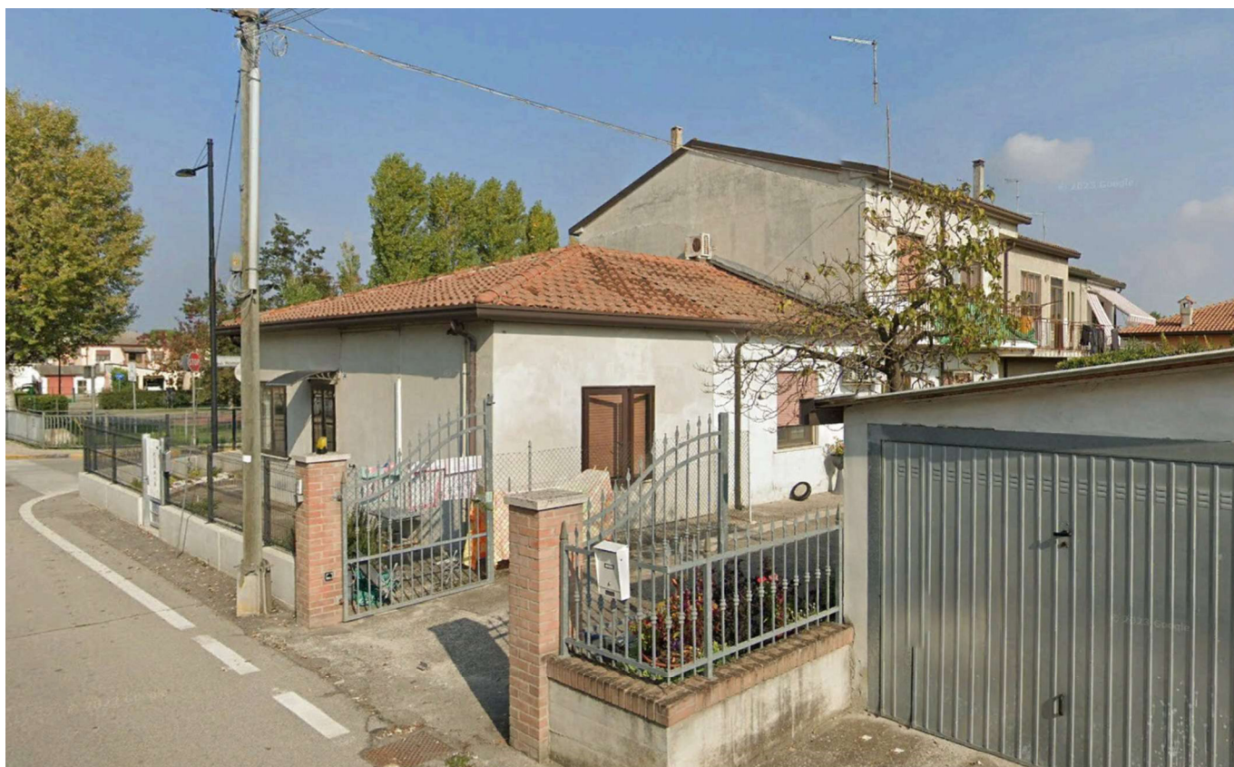
ACCESSO CARRAIO E PEDONALE
