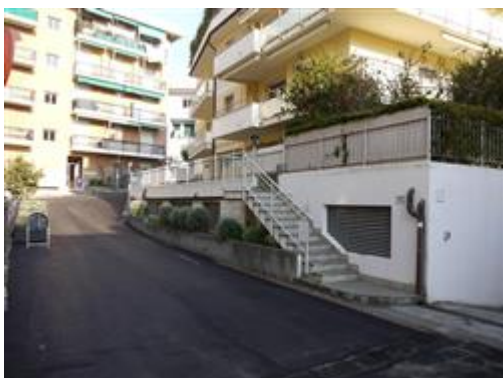
Condominio Marconi - vista scala di accesso alla terrazza comune
