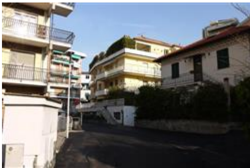
Condominio Marconi - viste generali esterne da sud est
