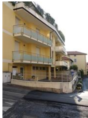
Condominio Marconi - vista fronte nord ovest e area comune al piano terreno
