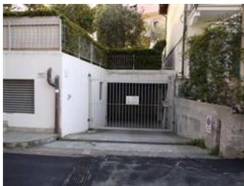
Condominio Marconi - vista rampa di accesso ai box interrati
