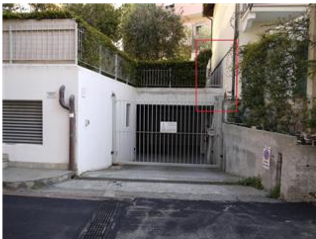
porzione di corte costituente copertura dell'intercapedine dei box interrati - individuazione
