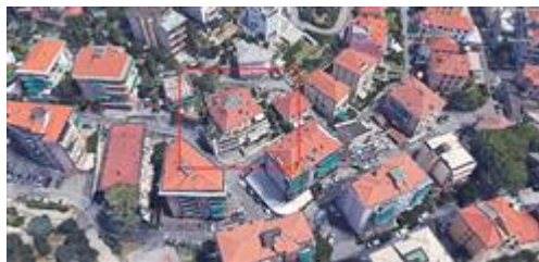
Fabbricato via Marconi civ. 32 vista generale
