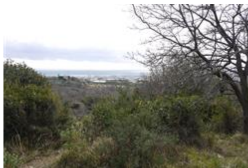
fabbricato di origien rurale allo stato di rudere
