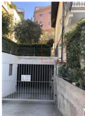
porzione di corte costituente copertura dell'intercapedine dei box interrati - vista fronte strada
