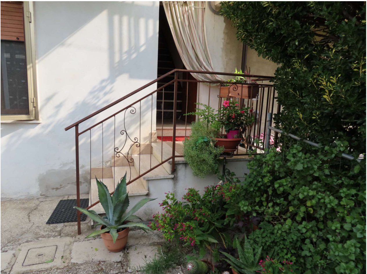
SCALA ESTERNA DI ACCESSO
