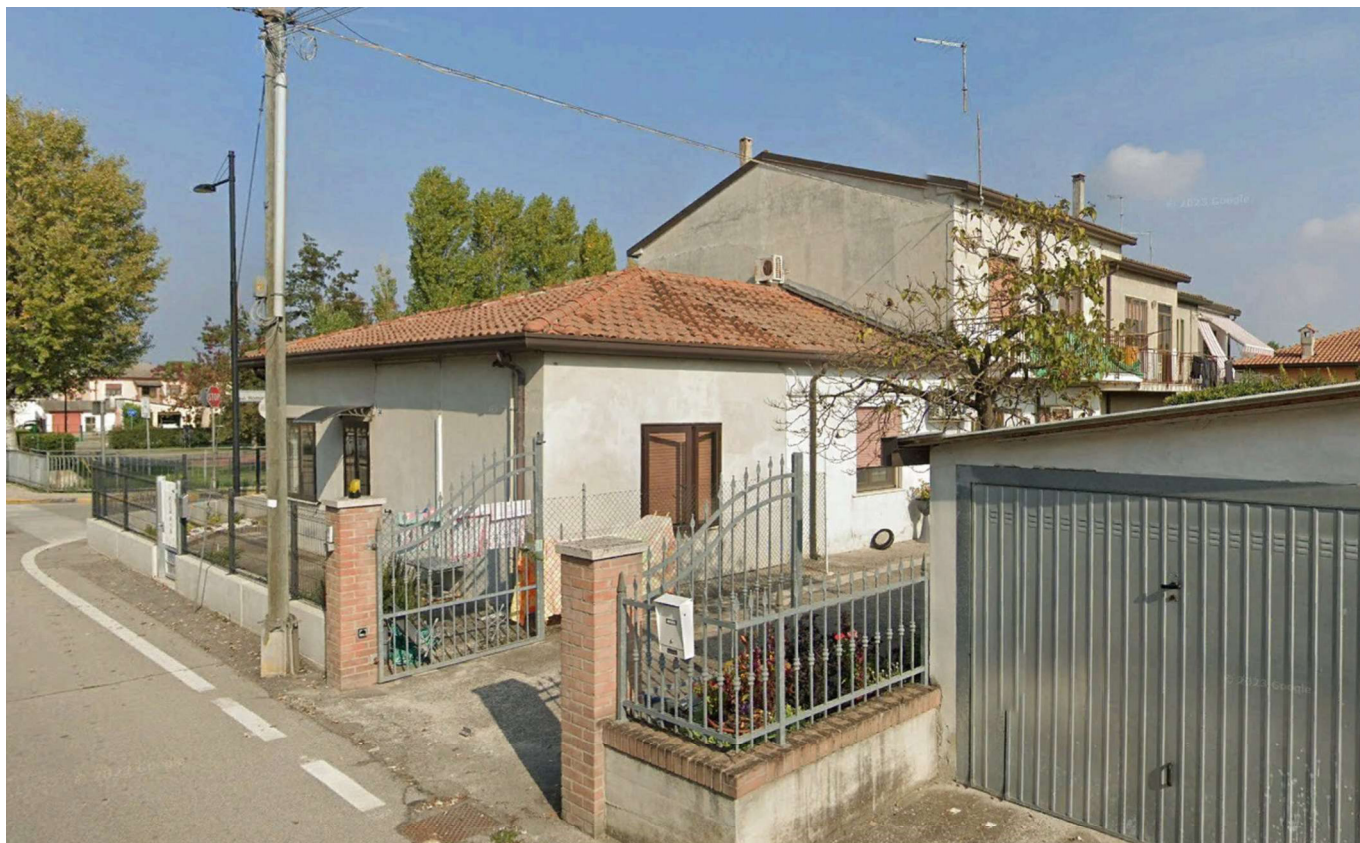
ACCESSO CARRAIO E PEDONALE
